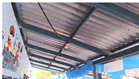
1.4 Sustitución de capotes por deterioro 21ML
