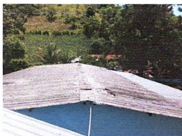
1.5 Sustitución de lamina troquelada por lamina troquelada aluznic calibre 26
