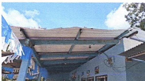
1.3 Mantenimiento de estructura de aulas y corredor (lijada y pintada estructura)
