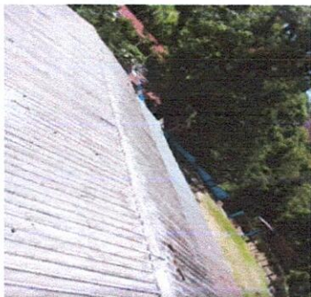
1.1 Desmontar techo de aulas y corredor; 10x21, 210m2
