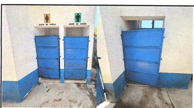
Foto 6: MANTENIMIENTOS DE PUERTAS DE SERVICIOS SANITARIOS, INCLUYENDO DESINSTALACIÓN DE PUERTA CON MARCO PARA UBICACIÓN EN EL NUEVO NIVEL DE PISO.
