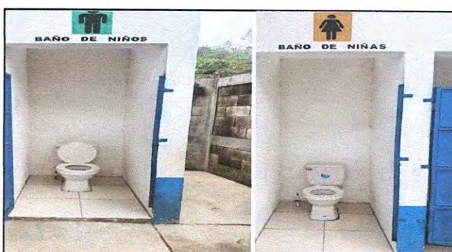
Foto 4: DEMOLICIÓN Y COLOCACIÓN DE PISO ANTIDESLIZANTE EN ÁREA DE SERVICIOS SANITARIOS.
