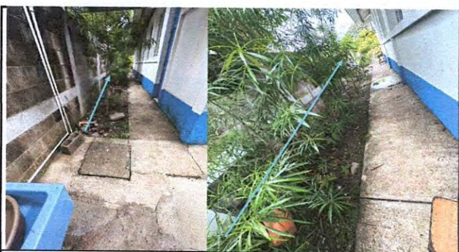
Foto 5: CAMBIO DE TUBERÍA PARA DRENAJE INCLUYENDO EXCAVACIÓN, NIVELACIÓN Y RELLENO COMPACTO.
