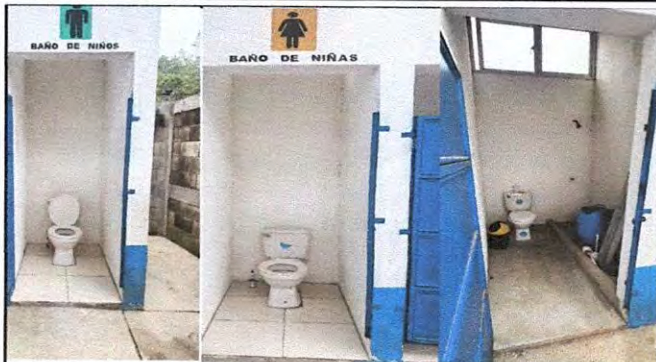
Foto1: DEMOLICIÓN DE PISO DE SERVICIOS SANITARIOS, RELLENO, COMPACTACIÓN EN ÁREA DE SERVICIOS SANITARIOS Y FUNDICIÓN CONTRAPISO EN SERVICIO SANITARIO.
