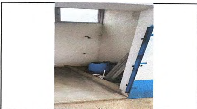
Foto 3: SUMINISTROS E INSTALACIÓN DE REGADERA INCLUYENDO DEMOLICIÓN Y EMPOTRAMIENTO A NUEVA ALTURA
