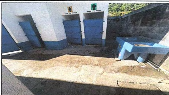
Foto 2: DEMOLICIÓN Y REPOSICIÓN DE PISO DE CONCRETO EN MODULO PATIO ESCOLAR FRENTE A BAÑOS
