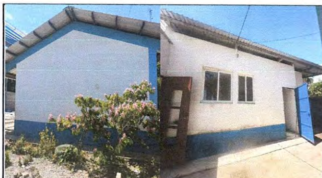
Foto 3: PINTUTA EN INTERIORES Y EXTERIORES DE MODULO AULAS, COCINA
