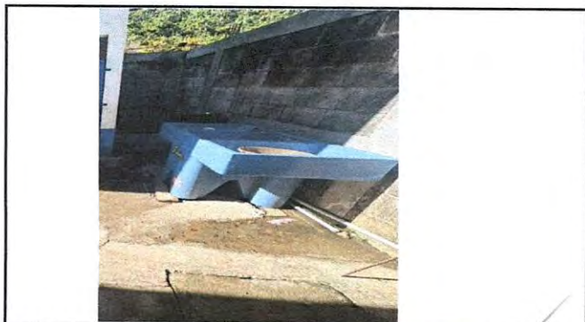
Foto 3: BASE DE CONCRETO PARA SOPORTE DE PILA+DRENAJE+REINSTALACIÓN DE PILA EXISTENTE
