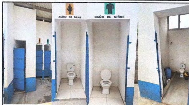
Foto1: PINTURA EN MUROS INTERIORES Y EXTERIORES DE LOS BAÑOS
