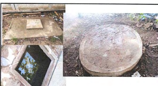
Foto 6: LIMPIEZA DE FOSA SEPTICA Y POZO DE ABSORCIÓN
