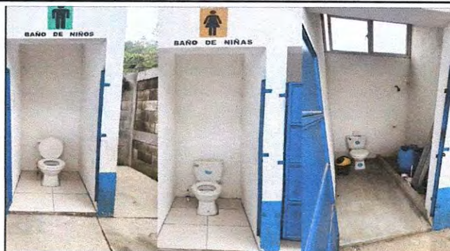
Foto 2: DESINSTALACIÓN, SUMINISTROS E INSTALACIÓN DE SANITARIOS
