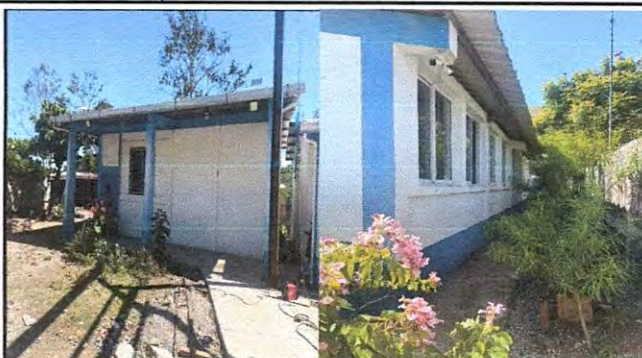
Foto 2: PINTUTA EN INTERIORES Y EXTERIORES DE MODULO AULAS, COCINA
