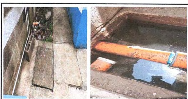
Foto 4: CAJA DE REGISTRO PARA DRENAJES CON CORTINA INCLUYENDO TAPADERA.
