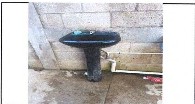
Foto 5: REINSTALACIÓN DE LAVAMANOS EXISTENTE, INCLUYENDO MODIFICACIÓN DE TUBERIA DE AGUA Y DRENAJE MAS ACCESORIOS.
