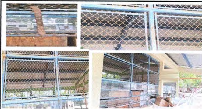
Foto 2: MANTENIMIENTO A ESTRUCTURA DE METAL DE VENTANAS
