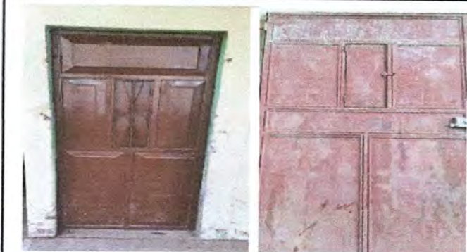
Foto1: MANTENIMIENTO A ESTRUCTURA (LIJADO, CAMBIO DE TUBO, CEPILLADO, SUJECIONES, APLICACIÓN DE PINTURA) EN PUERTAS DE COCINA
