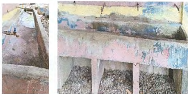
Foto 5: SUSTITUCIÓN DE PILA DE CEMENTO POR ESTRUCTURA DE CONCRETO DE DOS LAVADEROS CON MEDIDAS DE 1.25M X 0.90 M X 2.50 M
