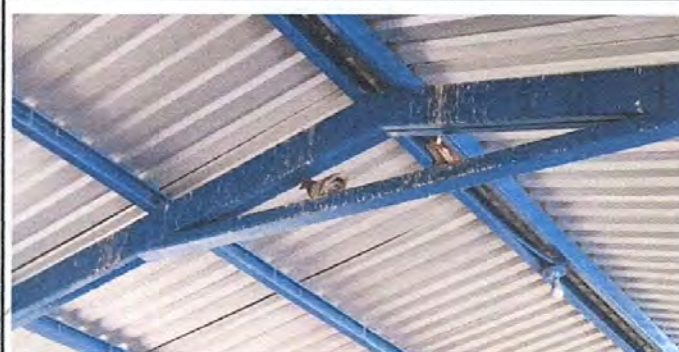
Foto 6: MANTENIMIENTO A ESTRUCTURA DE SOPORTE DE METAL (LIJADO, CAMBIO DE TUBO, CEPILLADO, SUJECIONES, APLICACIÓN DE PINTURA) EN EL TECHO
