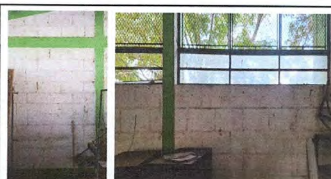
Foto 4: PINTURA EN MUROS EXTERIORES E INTERIORES
