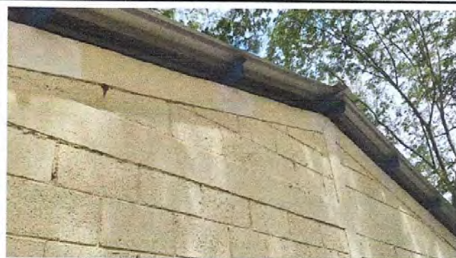
Foto 4: SELLADO DE GRIETAS CON CEMENTO CICLOPIO Y TAQUIQUES DE 7X19X39 ENTRE VIGA DE CORONA Y TECHO
