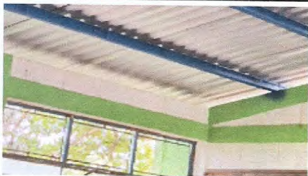
Foto 5: SELLADO DE GRIETAS CON CEMENTO CICLOPIO Y TAQUIQUES DE 7X19X39 ENTRE VIGA DE CORONA Y TECHO
