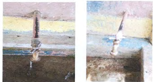
Foto 6: SUSTITUCIÓN DE LLAVE DE CHORRO
