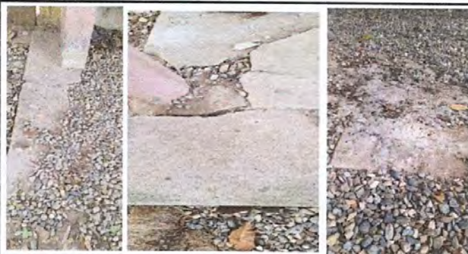
Foto 3: SUSTITUCIÓN DE TORTA DE CEMENTO
