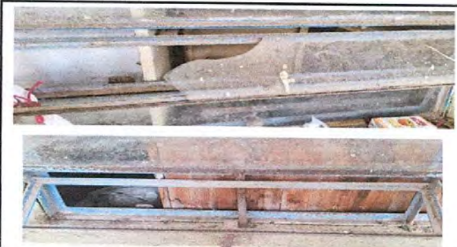
Foto 3: SUSTITUCIÓN E INSTALACIÓN DE VIDRIOS EN VENTANAS, MEDIDAS DE 0.20m x 0.80 m
