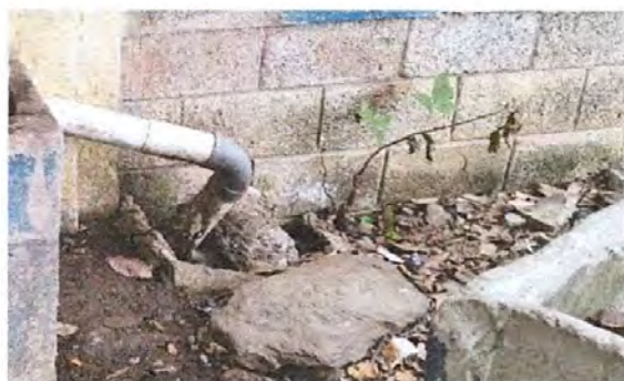
Foto 4: SUSTITUCIÓN TUBERÍA PVC LINEA PRINCIPAL DE AGUAS NEGRAS
