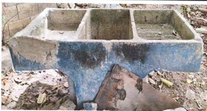
Foto 3: SUSTITUCIÓN DE PILA DE CEMENTO POR ESTRUCTURA DE CONCRETO DE DOS LAVADEROS CON MEDIDAS DE 1.25M X 0.90 M X 2.50 M
