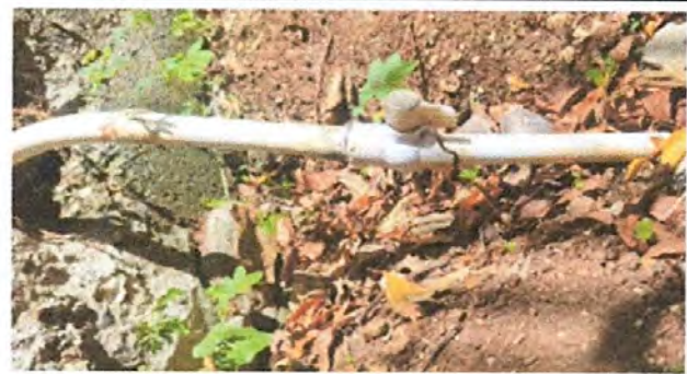
Foto 4: SUSTICIÓN E INSTALACIÓN DE TUBERÍA LINEAL PRINCIPAL EN RED DE AGUA POTABLE
