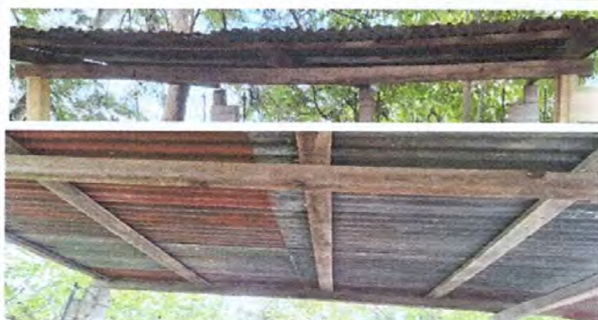
Foto 2: SUSTITUCIÓN DE SOPORTE DE MADERA POR METAL
