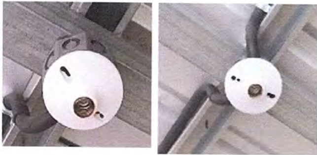
Foto1: SUSTITUCIÓN DE FOCOS AHORRADORES
