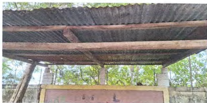
Foto1: SUSTITUCIÓN DE LÁMINA TROQUELADA POR LÁMINA ALUZINC
