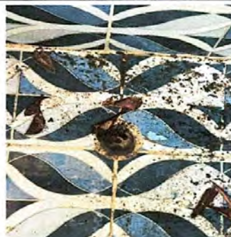
DESOBSTRUIR TUBERÍAS PVC LINEA DE DRENAJE
