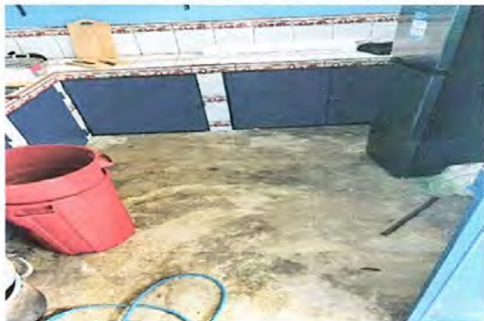
SUSTITUCIÓN DE PISO CERÁMICO EN COCINA
