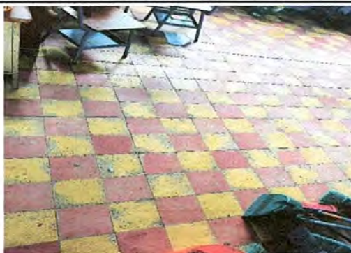
SUSTITUCIÓN DE PISO CERÁMICO EN AULA
