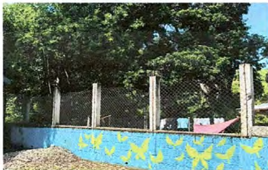
SUSTITUCIÓN DE TUBO HG Y MALLA GALVANIZADA
