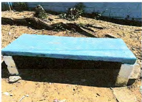
SUSTITUCIÓN DE BANCAS DE CONCRETO REFORZADO EN ÁREA DE PATIO
