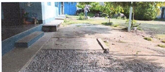
Foto 3: Sustitución de planchas de concreto en patio.
