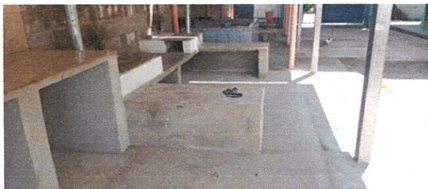
Foto 7: instalación de azulejo en muebles de concreto en cocina.
