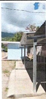
Foto 9: Suministro e instalación de canal de metal y bajada de agua pluvial en cocina.
