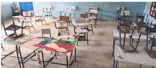
Foto 1: Instalaciones de piso cerámico mate en aula.
