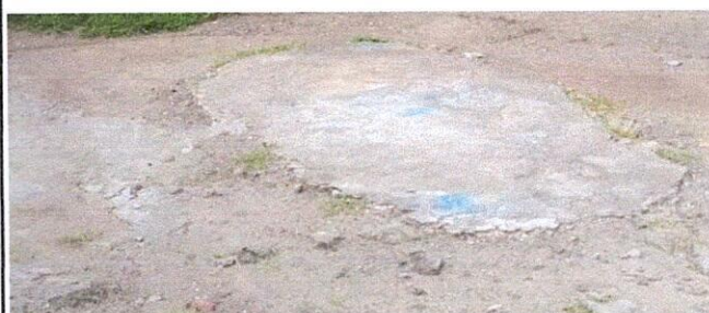
Foto 4: Sustitución de planchas de concreto en patio.
