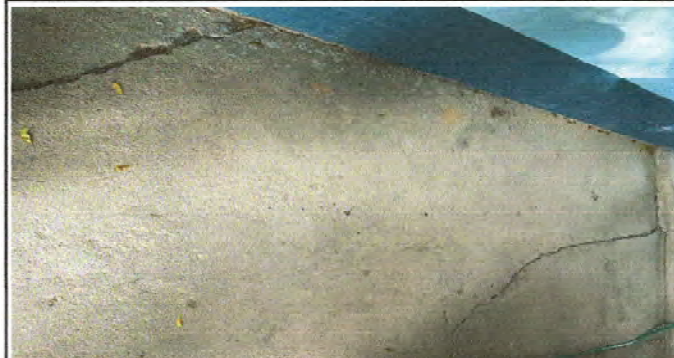
Foto 2: Sustitución de piso de torta de concreto
