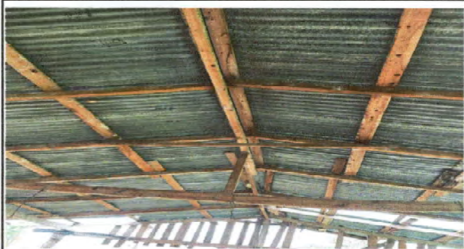
Foto 1 Sustitución de lamina calibre 26 y Sustitución de Estructura de Soporte
