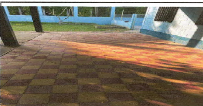
Foto 5: Sustitución de piso cerámico
