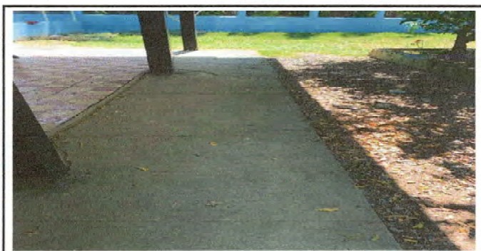
Foto 6: Reparación de piso de concreto
