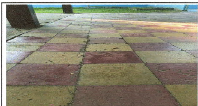
Foto 4: Sustitución de piso cerámico
