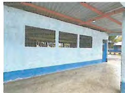
Foto 4: Balcones en mal estado a reparar 1X1.40 mts
