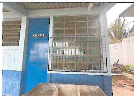
Foto 11: Sustitución e inslatación de balcones de metal 1.77 x 2.07 mts
