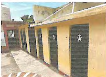
Foto 9: Pintura de baños
