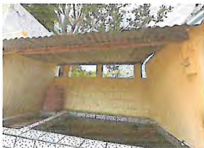
Foto 1: Estructura de madera y lamina sobre pila a sustituir
