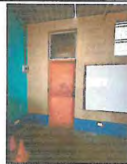
Foto 18: Sustitución puerta de metal en mal estado a pvc en salón de computación
