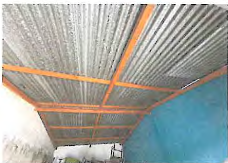
Foto 3: Estructura de madera y lamina del ambiente para bodega
