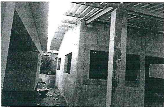
Foto 7: Suministro e instalación de lámina troquelada cal. 26
