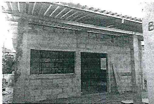
Foto 8: Suministro e instalación de lámina troquelada cal. 26
