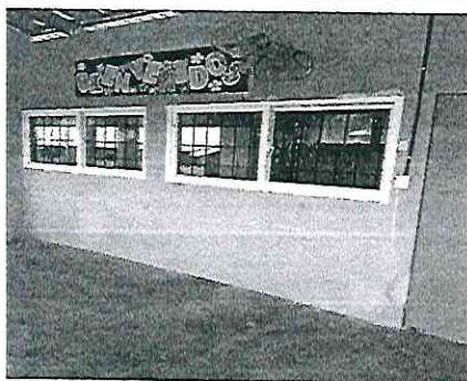
Foto 5: Suministro e instalación de ventanas corredizas de PVC vidrio oscuro de 5mm. De grosor
