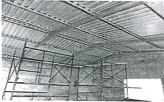
Foto 19: Suministro e instalación de lámina troquelada cal. 26 en modulo cocina
