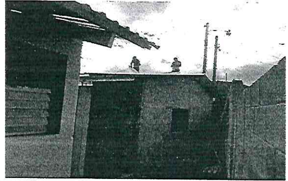
Foto 20: Suministro e instalación de lámina troquelada cal. 26 en modulo cocina
