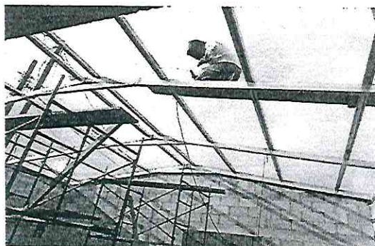
Foto 17: Suministro e instalación de estructura metálica para cocina
