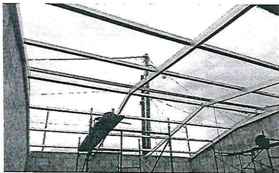
Foto 13: Suministro e instalación de estructura metálica para cocina
