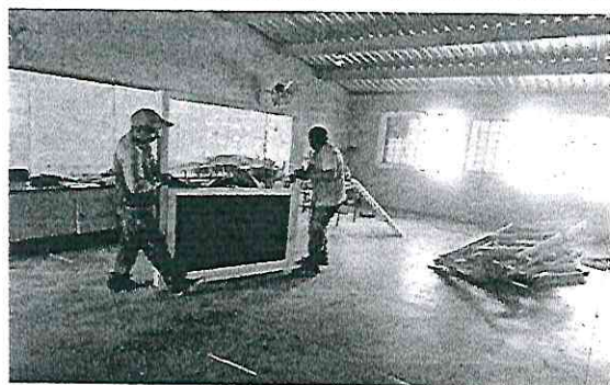
Foto 5: Suministro e instalación de ventanas corredizas de PVC vidrio oscuro de 5mm. De grosor
