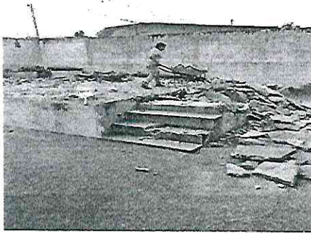
Foto 7: Desinstalación de graderio de concreto
