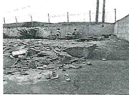
Foto 8: Desinstalación de graderio de concreto
