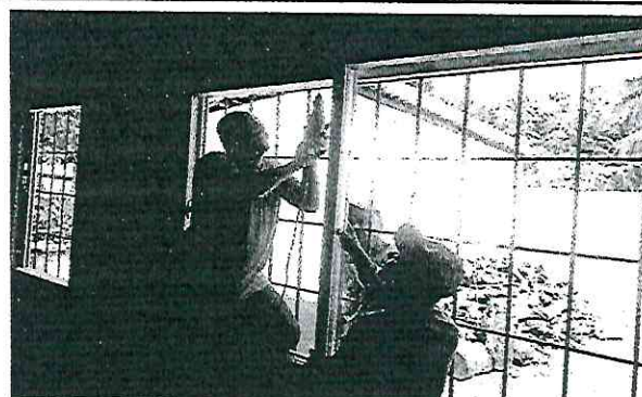
Foto 4: Suministro e instalación de ventanas corredizas de PVC vidrio oscuro de 5mm. De grosor
