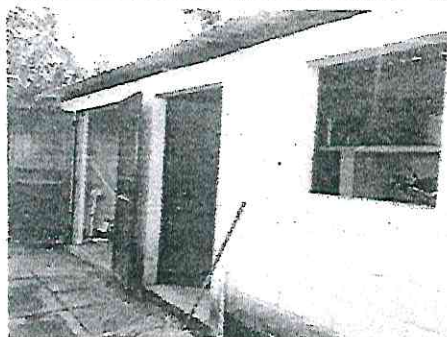
Foto 1: Repello, cernido y pintura en paredes
