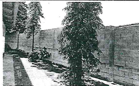
Foto 12: Repello, cernido y pintura en paredes interiores y exteriores del muro perimetral
