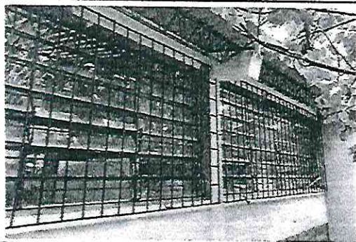
Foto 5: Reparación de estructura metálica de balcones de ventanas incluye (Lijado, cepillado y pintura)
