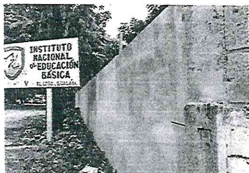
Foto 13: pintura en paredes interiores y exteriores del muro perimetral
