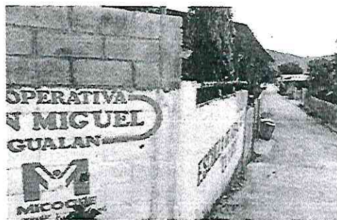
Foto 16: pintura en paredes interiores y exteriores del muro perimetral
