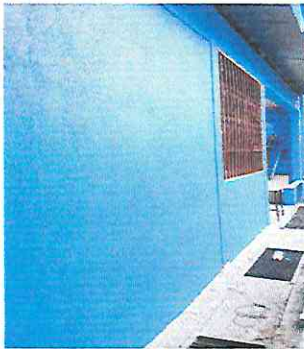
Foto 14: Pintura en muros interiores y exteriores
