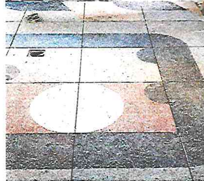
Foto 14: Suministro e instalación de piso cerámico antideslizante en modulo de cocina
