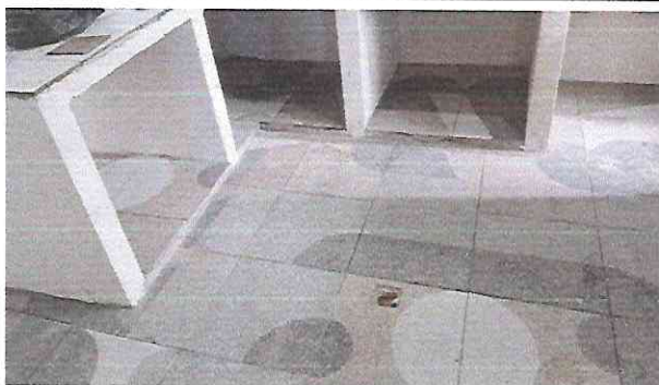
Foto 5: Suministro e instalación de mesa de trabajo y sustitución de piso de torta de concreto por piso cerámico antideslizante
