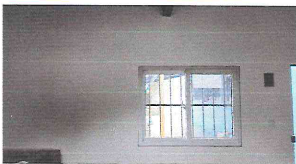
Foto 3: Suministro e instalación de ventanas corredizas
