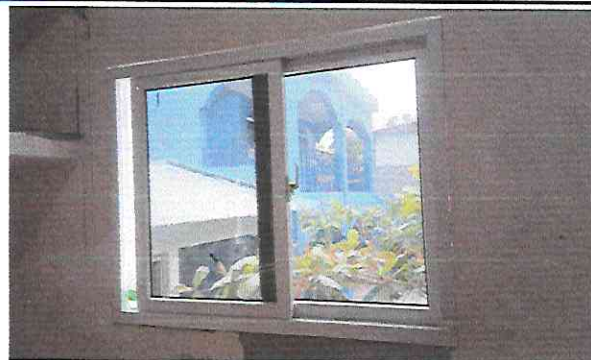
Foto 4: Suministro e instalación de ventanas corredizas
