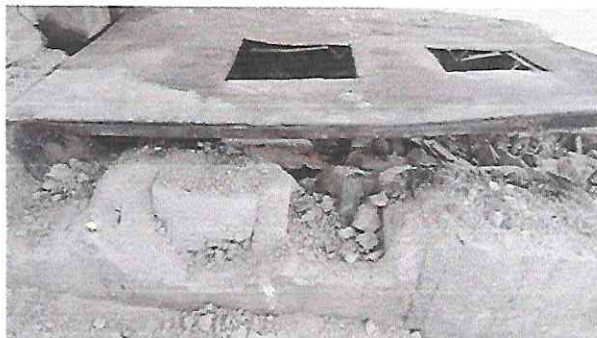
Foto 1: Sustitución de plancha de metal dañada y fabricacion de polleton
