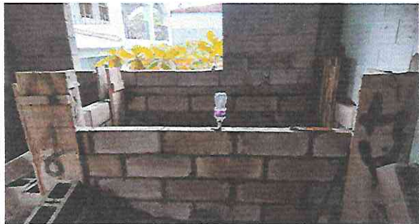
Foto 13: Suministro e instalación de pila de concreto
