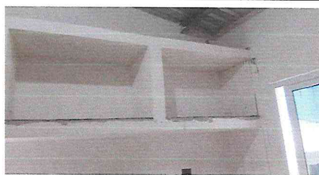
Foto 4: Suministro e instalación de gabinete de concreto
