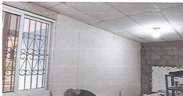
Foto 7: Repello, cernido y pintura en aulas
