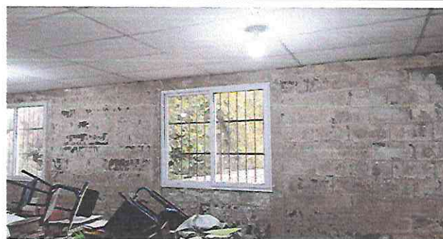
Foto 6: Reparación de columna de humedad, Repello en modulo de aulas
