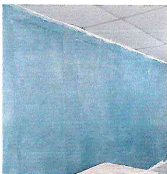
Foto 3: Repello, cernido y pintura en modulo de aulas
