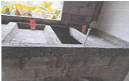
Foto 14: Suministro e instalación de pila de concreto
