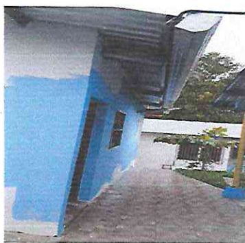
Foto 5: Repello, cernido y pintura en modulo de aulas
