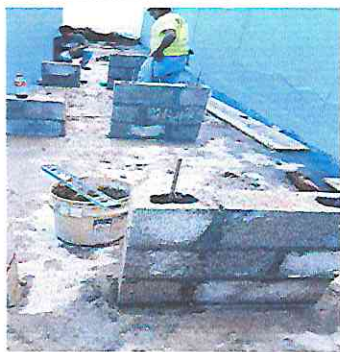
Foto 17: Suministro e instalación de mesa de concreto y bancas para uso de comedor
