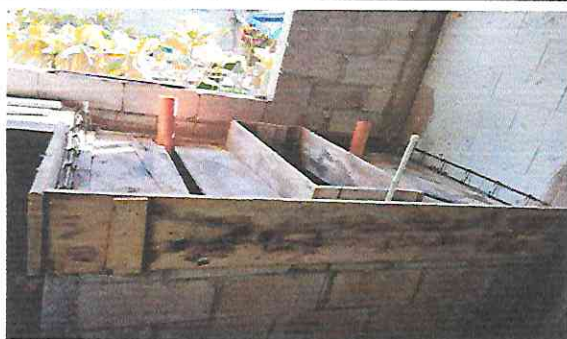
Foto 11: Suministro e instalación de pila de concreto
