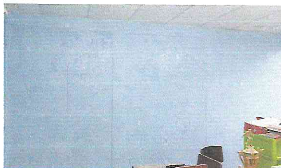
Foto 2: Repello, cernido y pintura en modulo de aulas
