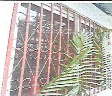
Foto 5: Mantenimiento a balcón de metal de 1.08 mts de ancho por 1.20 mts de alto (Incluye lijado, cepillado y pintura)
