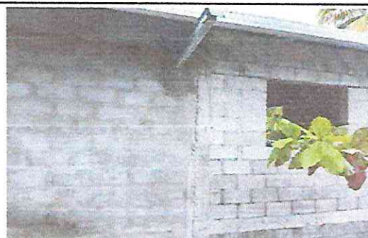
Foto 6: Suministro e instalación de balcones de metal, repello, cernido y pintura en paredes
