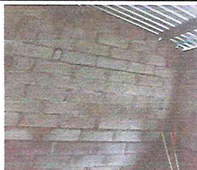
Foto 8: Repello, cernido y pintura en paredes en modulo de cocina
