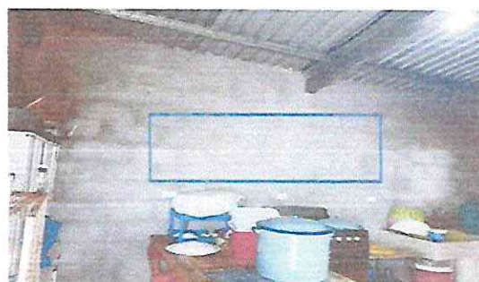
Foto 12: Suministro e intalación de gabinete de concreto de 1.50 mts de largo por 0.40 mts de ancho y de 0.80 mts de alto
