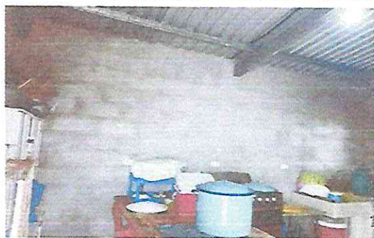
Foto 3: Repello, cernido y pintura en paredes en modulo de cocina
