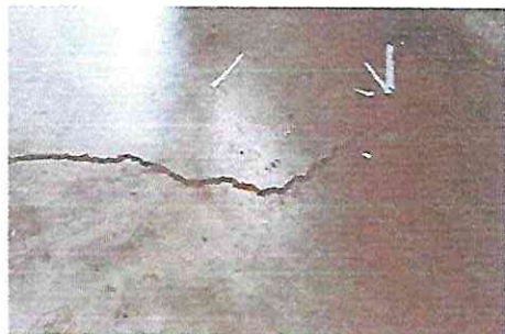
Foto 13: Sustrución de piso de torta de concreto por piso cerámico
