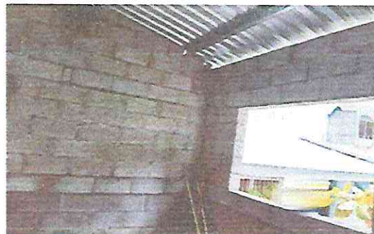
Foto 2: Suministro e instalación de ventanas corredizas de material de pvc, repello, cernido y pintura en paredes en modulo de cocina
