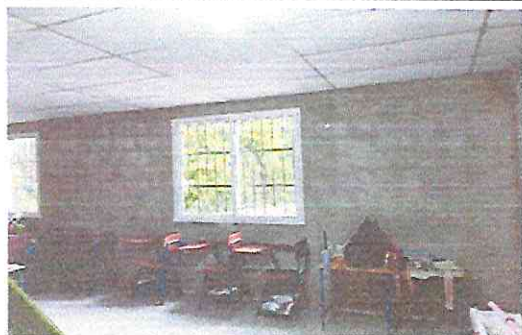
Foto 7: Repello, cernido y pintura en paredes en modulo de aulas
