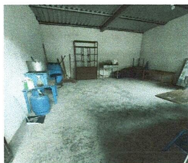
Foto 10: sustitucion de piso liso por piso ceramico
