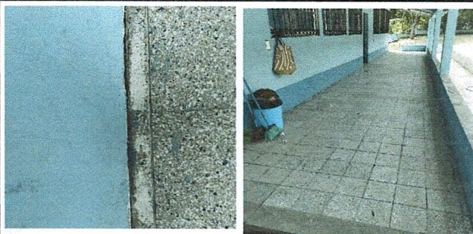
Foto 1: desinstalacion de piso granito aula y corredor
