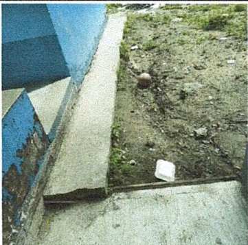
Foto 1: sustitucion de banqueta
