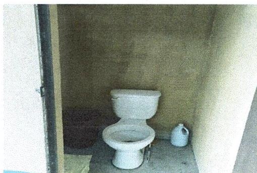
Foto 4: sustitucion e instalacion de inodoro para adultos
