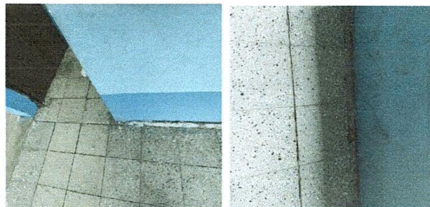
Foto 2: instalacion de piso ceramico
