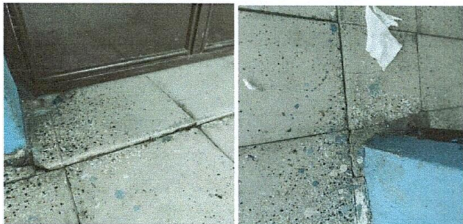
Foto 1: desinstalacion de piso granito aula y corredor
