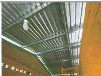
Foto 3: Cerramiento de Contorno de Ambientes, Cielo Razo PVC para Dirección y Bodega. Para EORM.CASERIO QUEBRADA LARGA, ALDEA GUARANJA.
