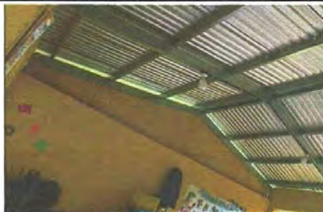
Foto 9: Cambio de Cumbre de Madera a Tabique de Blocks de 20'20'40 y Mejoras al Sistema Eléctrico y Suministro e Instalación de Cielo Razo de PVC. Para EORM. CASERIO QUEBRADA LARGA, ALDEA GUARANJA.
