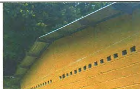
Foto 4: Cerramiento de Contorno de Ambientes. Para EORM.CASERIO QUEBRADA LARGA, ALDEA GUARANJA.
