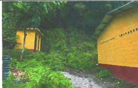
Foto 10: Mantenimiento a Puertas de Módulo de Servicios Sanitarios y Fundición de Rampa para Acceso a los Sanitarios; Suministro y Aplicación de Pintura. Para EORM. CASERIO QUEBRADA LARGA, ALDEA GUARANJA.
