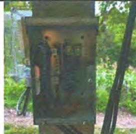
Foto 8: Reparación y Rehabilitación de Sistema Eléctrico. Para EORM. CASERIO QUEBRADA LARGA, ALDEA GUARANJA.
