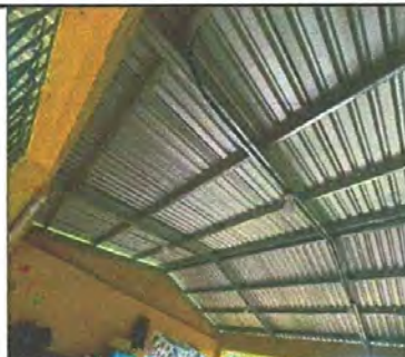
Foto 2: Suministro E Instalación de CIELO RAZO PVC, DUELA BLANCA (Dentro de Aula, Dirección-Bodega), Cerramiento de Contorno de Ambientes, Mantenimiento Balcones, Puertas, Mejoras al Sistema Eléctrico. Para EORM.CASERIO QUEBRADA LARGA, ALDEA GUARANJA.
