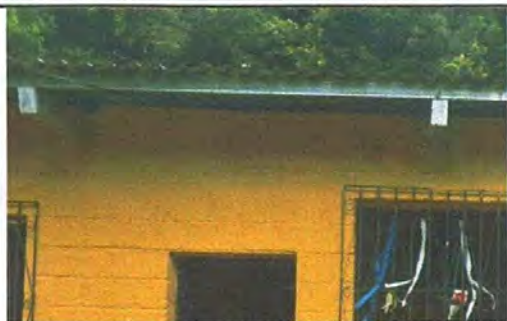
Foto 1: Suministro E Instalación de CIELO RAZO PVC, DUELA BLANCA, Cerramiento de Contorno de Ambientes, Mantenimiento Balcones, Puertas, Mejoras al Sistema Eléctrico. Para EORM.CASERIO QUEBRADA LARGA, ALDEA GUARANJA.
