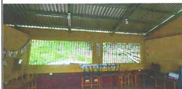
Foto 12: Mantenimiento a Balcones Metálicos, Suministro e Instalación de Ventanas PVC. Suministro e Instalación de Cielo Razo PVC. Suministro e Instalación de Lámparas LED Y Ventiladores de 3 Aspas y Cerramiento con Tabique de Block en 3 Cumbresas. Para EORM. CASERIO QUEBRADA LARGA, ALDEA GUARANJA.
