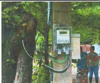
Foto 7: Reparación y Rehabilitación de Sistema Eléctrico. Para EORM. CASERIO QUEBRADA LARGA, ALDEA GUARANJA.
