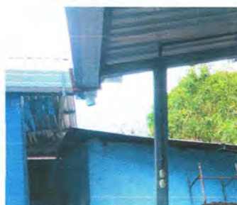
Foto 15: Sustitución de bajada de agua pluvial de PVC por metal
