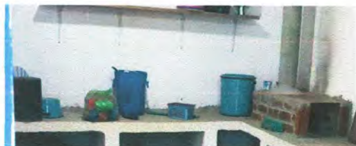
Foto 13: Instalación de azulejo en mueble de cocina
