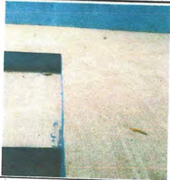
Foto 7: Sustrución de piso de torta de concreto por piso cerámico
