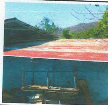
Foto 4: Sustitución de lámina por lámina troquelada aluzinc calibre 26 en el área de la cocina
