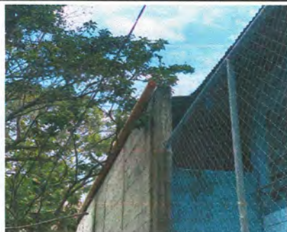
Foto 17: Sustitución de canal de PVC por canal de metal
