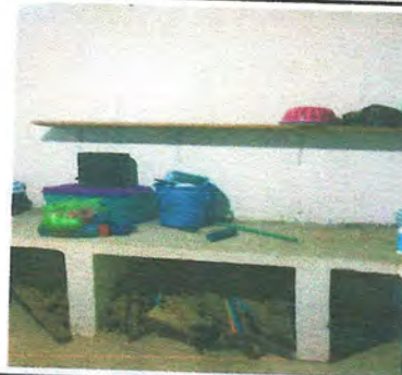
Foto 2: Suministro de gabinetes en la parte frontal de la pared en el área de cocina
