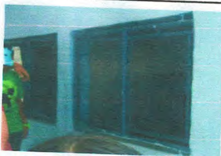
Foto 5: Sustitución de ventanas de malla por ventanas de material metálico
