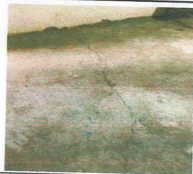
Foto 10: Sustrución de piso de torta de concreto por piso cerámico
