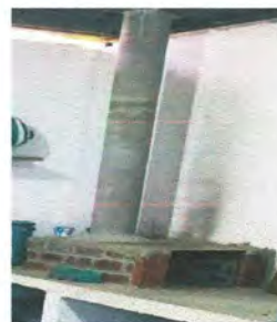
Foto 14: Instalación de azulejo en estufa rural
