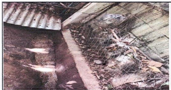
Foto 6: Suministro E Instalación de Cuneta Prefabricada para Evacuación de Agua Pluvial
