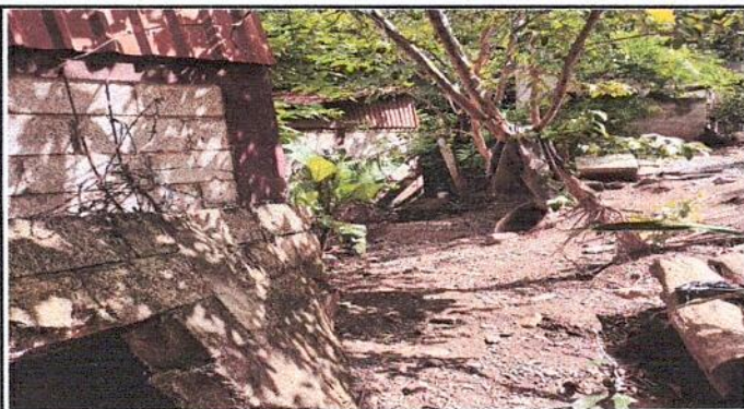
Foto 1: PROTECCIÓN Y REPARACIÓN A MURO PERIMITRAL POR COLAPSO POR LLUVIAS
