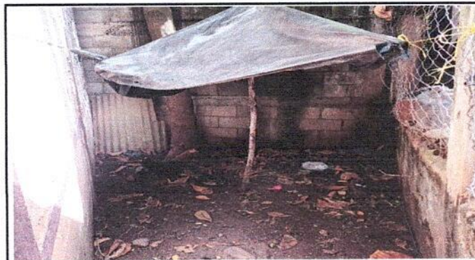
Foto 4: PROTECCIÓN Y REPARACIÓN A MURO PERIMITRAL POR COLAPSO POR LLUVIAS
