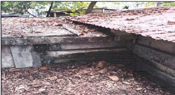
Foto 3: REPARACIÓN DE LOSA EN AULA PRIMERO "C" Y BODEGA
