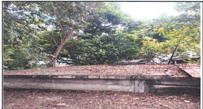
Foto 2: REPARACIÓN DE LOSA EN AULA PRIMERO "C" Y BODEGA
