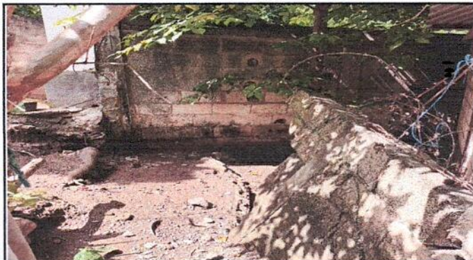
Foto 2: PROTECCIÓN Y REPARACIÓN A MURO PERIMITRAL POR COLAPSO POR LLUVIAS
