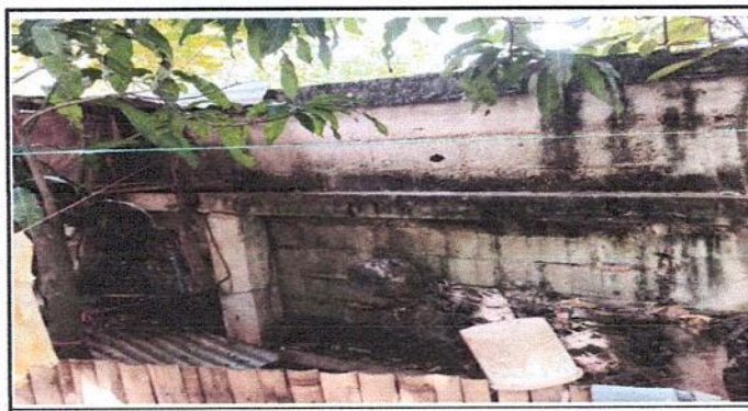
Foto 5: Alisado Final para Pared Colindante y Paredes Aulas Posterior
