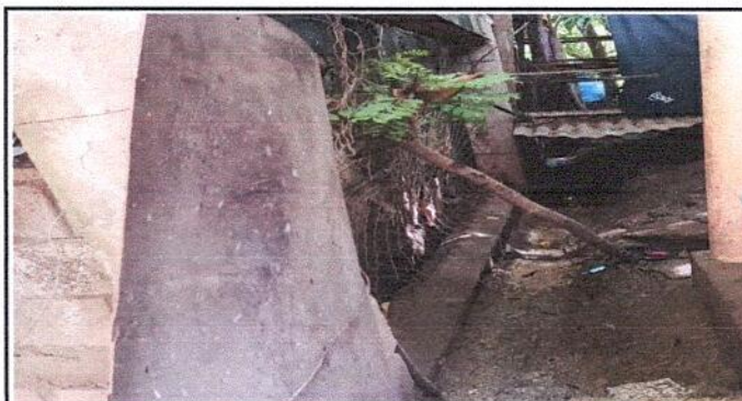
Foto 5: Suministro E Instalación de Cuneta Prefabricada para Evacuación de Agua Pluvial
