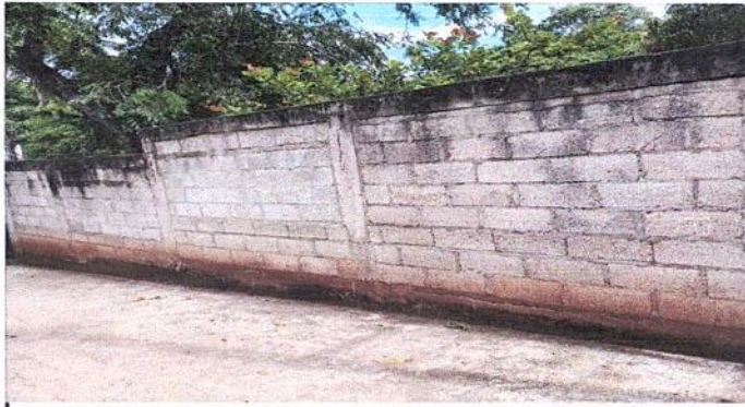
Foto1: Alisado Final para muro perimetral parte frotal. (Repello)
