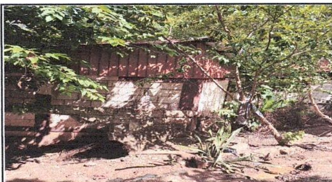
Foto 3: PROTECCIÓN Y REPARACIÓN A MURO PERIMITRAL POR COLAPSO POR LLUVIAS
