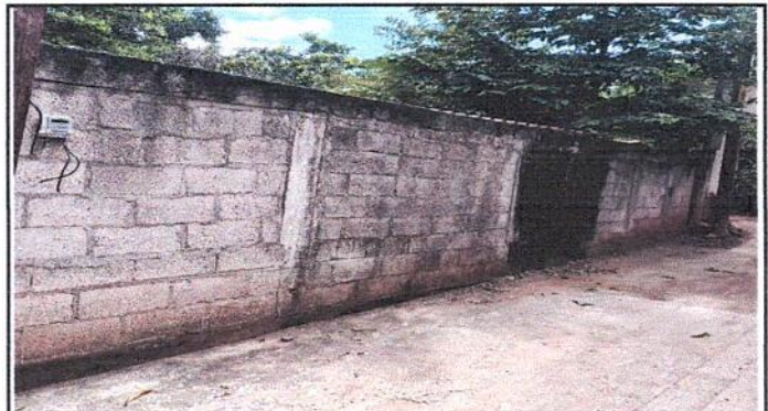
Foto 2: Alisado Final para muro perimetral parte frotal. (Repello)
