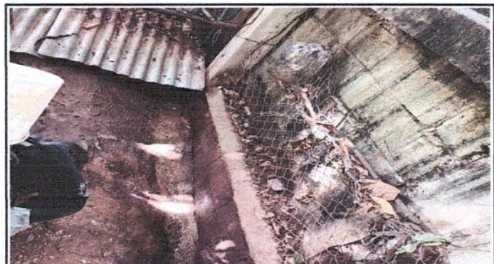
Foto 4: Suministro E Instalación de Cuneta Prefabricada para Evacuación de Agua Pluvial
