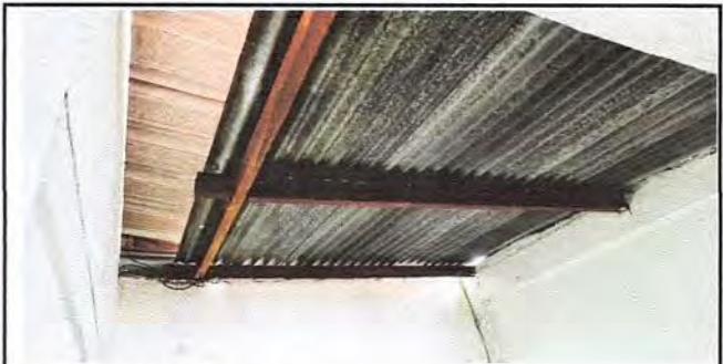
Foto 6: 6. Pasillo 6.1 Sustitución de techo.
