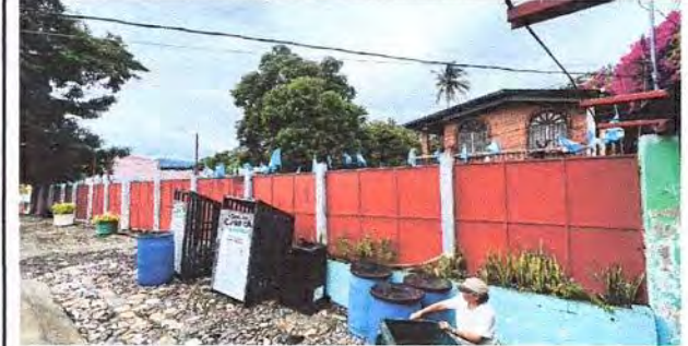
Foto 4: 4. Muro 4.3 Mantenimiento de tableros de muro y asegurarlos a las columnas.
