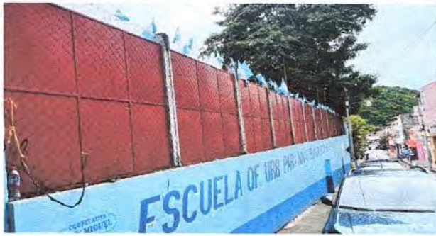
Foto 3: 4. Muro 4.2 Retiro de malla que está sobrepesta, de todo el muro.
