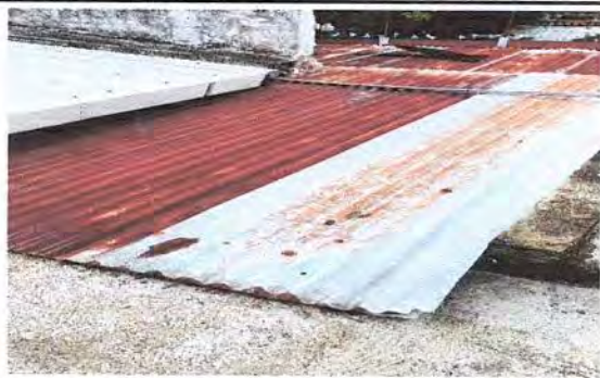
Foto1: 6. Pasillo 6.1 Sustitución de techo. Vista de arriba
