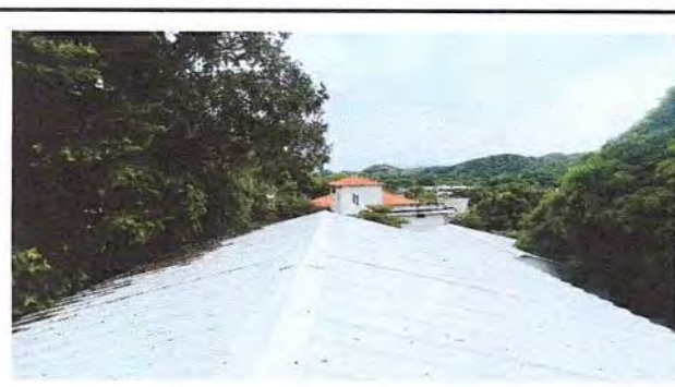
Foto 4: 3.Aulas 3.3 Mantenimiento de techo exterior izquierdo. ( aplicación de pintura)
