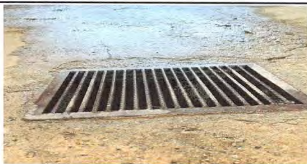
Foto 5: 2. Patio 2.2 sustitución de caja recolectora de agua pluvial dimensiones de 1x 0.45x0.4 m. Se conectarán las líneas de drenaje de agua pluvial.
