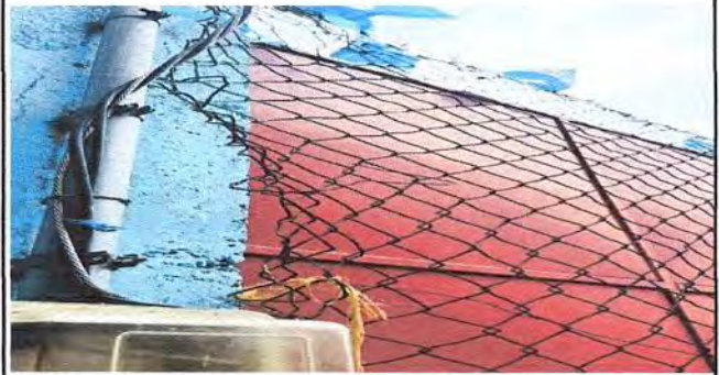
Foto 2: 4. Muro 4.2 Retiro de malla que está sobrepesta, de todo el muro.
