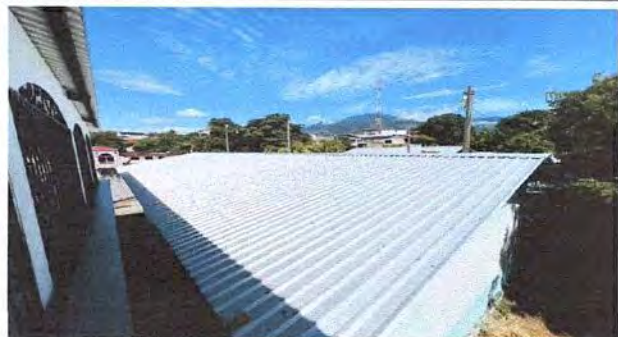
Foto 1: 3 Aulas: 3.1 Mantenimiento de techo módulo exterior cancha (aplicación de pintura)
