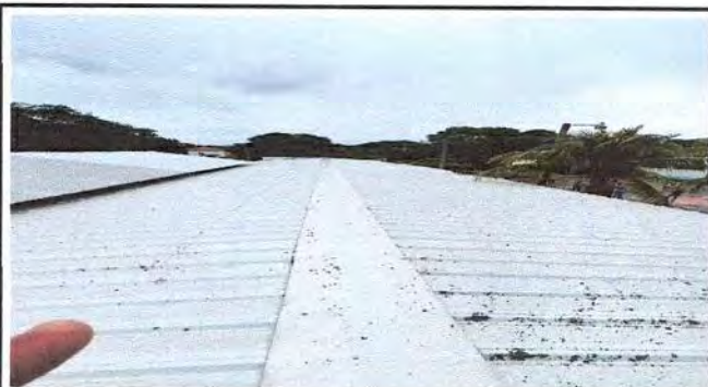
Foto 3: 3. Aulas 3.2 Mantenimiento de techos módulo interior lado derecho. (aplicación de pintura)
