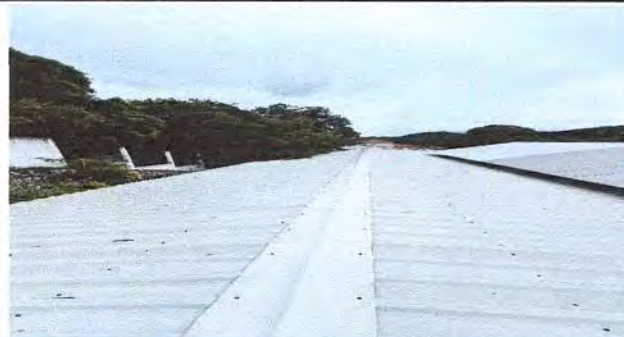
Foto 2: 3. Aula 3.2 Mantenimiento de techos módulo interior lado izquierdo. (aplicación de pintura)
