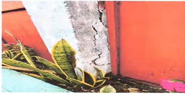
Foto 1: 4. Muro 4.1 Restauración de columnas.
