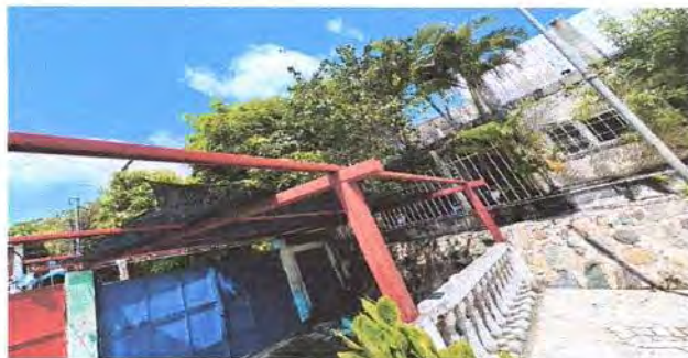
Foto 1: 1. Entrada Principal: 1.1 Sustitución de estructura metálica 1.2 sustitución e instalación de lámina troquelada aluzinc calibre 26 1.3 suministro e instalación de canal de metal 1.4 suministro e instalación de bajada de agua pluvial. Es el área donde se forman las alumnas para entregarlas a los padres de familia y están en el sol.
