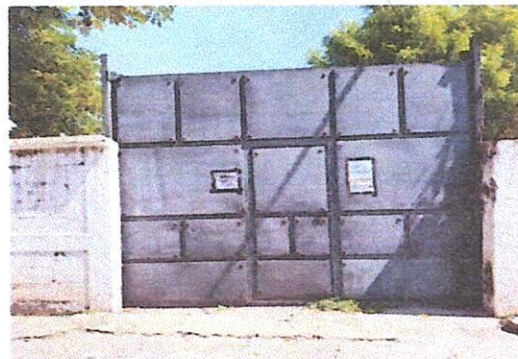
3.1 Reparación, lijado y pintado de portón de 4X3; 12 M2
