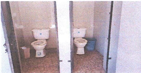
1.4 Reparación de Baños y accesorios
