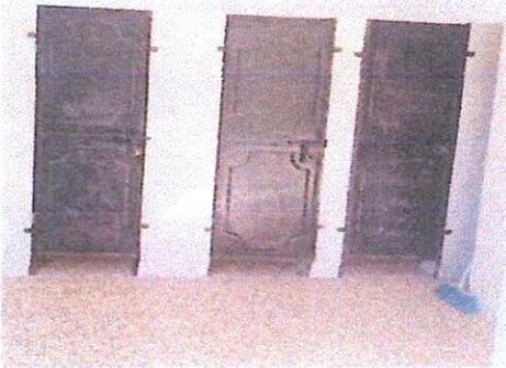
1.2 Pintura de puerta de baños (lijada y pintada) 1.50x2:3m2
