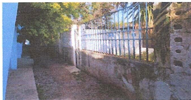
4.3 Limpieza y eliminación de suciedad y hongos, aplicación de capa base y luego encalar las paredes exteriores de aula 7X63; 441M2
