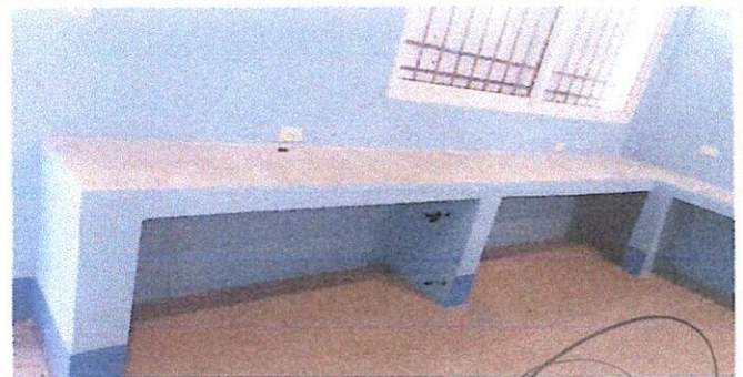
2.1 Fabricación e instalación de 5 puertas de gabinete de cedro de 0.75x1.80x5; 6.75M2
