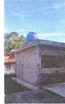
1.1 Instalación de rotoplast para distribución de agua para sanitario con capacidad de 1700lts, (Este rotoplast se instalará en cocina y el nuevo se instalata acá para almacenar más agua por razón de escasez y no perder de utilizar el pequeño.)
