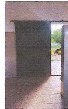
1.3 Pintura de Puerta Principal de baños (lijada y pintada); 1.50 x 2; 3m2
