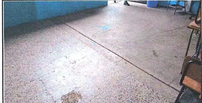
Foto 6: Instalación de Piso Cerámico Mate en Aulas
