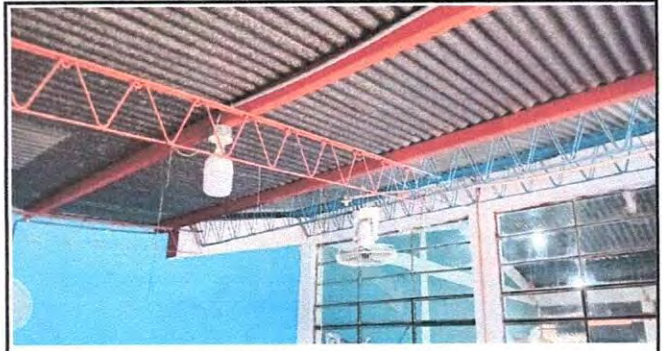
Foto 4: Sustitución de Lámina Ondulada por Lámina Troquelada y Estructura de Soporte de Metal en Aulas
