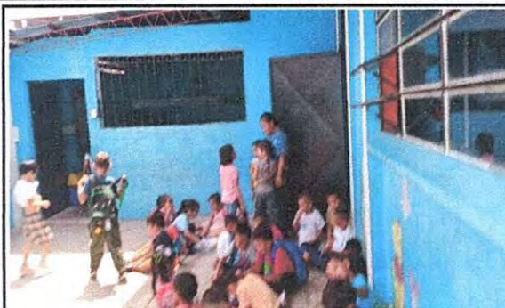
Foto 8: Pintura en Muros Interiores y Exteriores en Aulas
