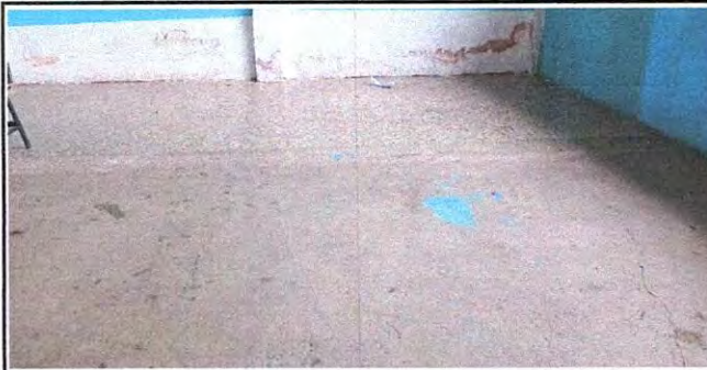
Foto 5: Instalación de Piso Cerámico Mate en Aulas
