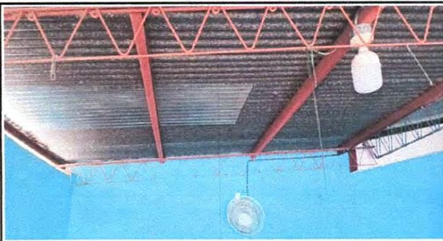
Foto 3: Sustitución de Lámina Ondulada por Lámina Troquelada y Estructura de Soporte de Metal en Aulas
