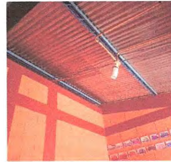
Foto 2: Instalación de cielo falso
