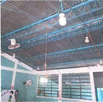
Foto 1: Instalación de cielo falso.
