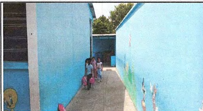
Foto 7: Pintura en Muros Interiores y Exteriores en Aulas
