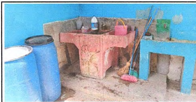
Foto 11: Sustitución de Pila de Concreto por Pila de Block y Cemento en Cocina
