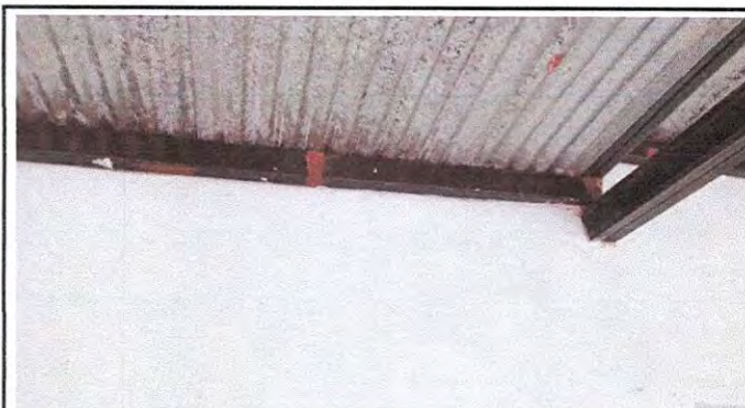
Foto 4: Sustitución de Estructura de Soporte de Metal en Aulas
