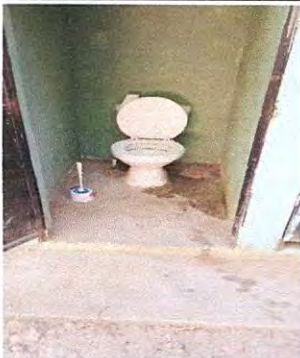
Foto 7: Sustitución de Inodoros en Baños
