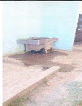
Foto 8: Sustitución de Pila de Concreto por Pila de Block y Cemento de un lavadero
