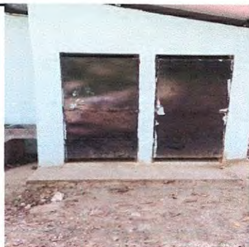
Foto 9: Mantenimiento de Puertas en Baños (Lijar y Pintar)
