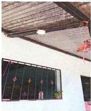
Foto 1: Sustitución de Luminarias en Aulas
