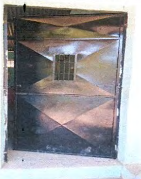
Foto 3: Mantenimiento de Puertas en Aulas (Lijar y Pintar)
