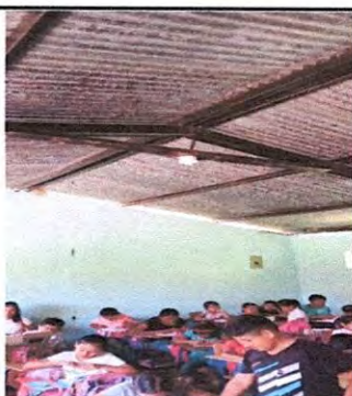
Foto 5: Sustitución de Lámina Ondulada por Lámina Troquelada Calibre 26 en Aulas
