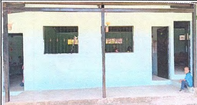
Foto 2: Instalación de Ventanas PVC en Aulas
