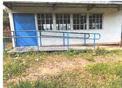
8.2 REPARACION DE BANQUETA DE CONCRETO (INSTALACION DE BANQUETA NUEVA)
