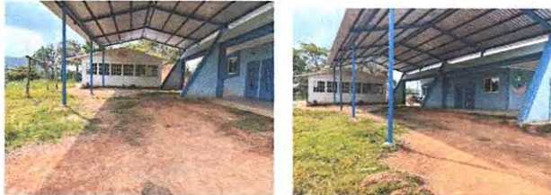
6. PISO (INSTALACION DE TORTA DE CONCRETO NUEVA)
