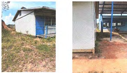
8.2 REPARACION DE BANQUETA DE CONCRETO (INSTALACION DE BANQUETA NUEVA)
