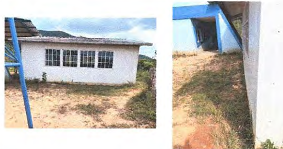
8.2 REPARACION DE BANQUETA DE CONCRETO (INSTALACION DE BANQUETA NUEVA)
