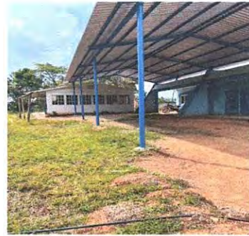
7.1 SUSTITUCION DE CANAL DE METAL (INSTALACION DE CANALES DE METAL NUEVO)
