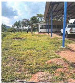
7.3 REPARACION DE BAJADAS DE AGUA PLUVIAL TUBO PVC DE 3" (INSTALACION DE TUBOS DE PVC DE 3" NUEVOS)
