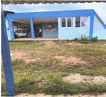
1. CUBIERTA Y 2. ESTRUCTURA DE TECHO (INSTALACION DE LAMINA CAL 26 DE ALUZINC Y ESTRUCTURA METALICA NUEVA)
