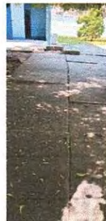
Foto 10: sustitución de planchas de concreto en patio.
