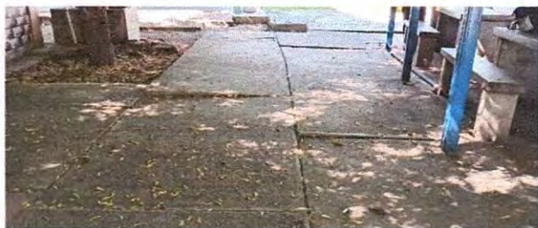
Foto 9: sustitución de planchas de concreto en patio.
