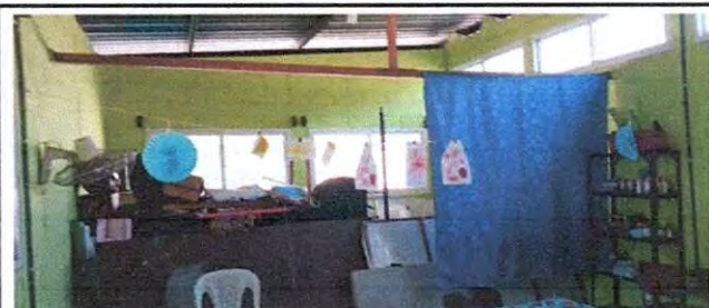
Foto3: suministro e instalación de división de tabla yeso de dos hojas abatible en aulas.
