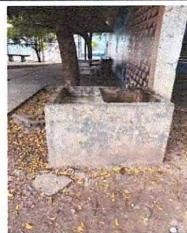
Foto 6: sustitución de pila de block en patio.
