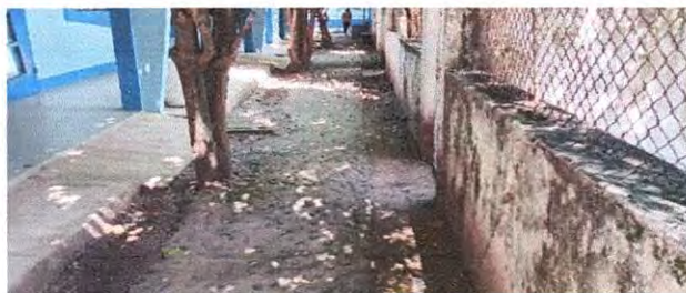
Foto 8: sustitución de banquetas en patio.
