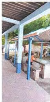
Foto 7: sustitución de canal de tubo PVC por canal de metal en patio.
