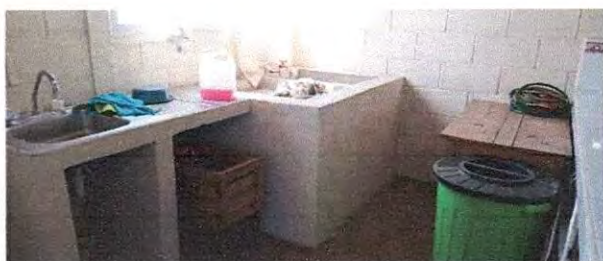
Foto 5: suministro e instalación de azulejo en pila de cocina.
