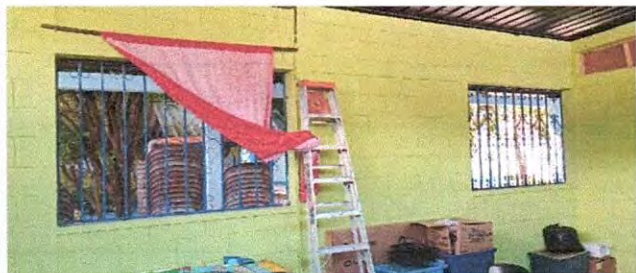
Foto 1: suministro e instalación de ventanas PVC en aulas.
