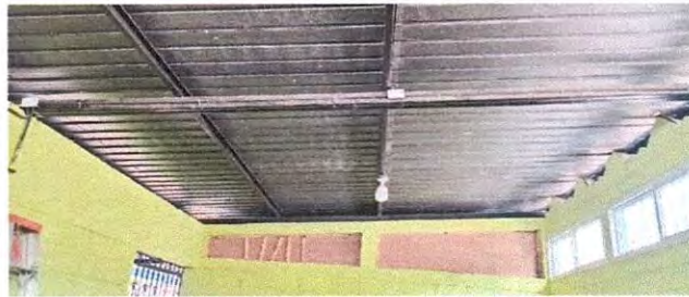
Foto 2: suministro e instalación de cielo falso PVC en aulas.
