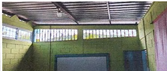
Foto 4: suministro e instalación de muro de Block en lugar de balcones de metal en aulas.
