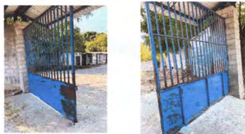
12.1 MANTENIMIENTO A PORTONES DE METAL (Modificacion cerrado todo el porton medida 6x3m, incluye puerta de acceso de 1x2m)
