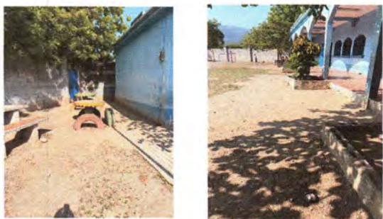
6.5 SUSTITUCION DE PISO DE TORTA DE CONCRETO (Instalacion de torta de concreto nueva)
