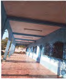
17. REPARACION DEL SISTEMA ELECTRICO (Sustitucion de lampara 2x40 y Sustitucion de Plafonera)
