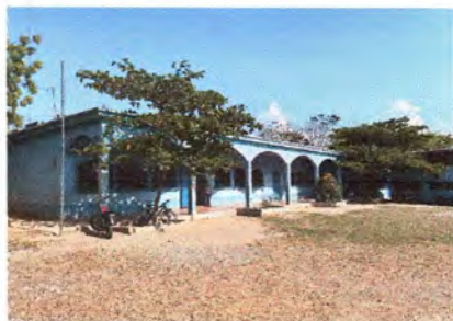
9.1 PINTURA EN MUROS EXTERIORES E INTERIORES (pintura de color azul y celeste de marca Corona linea Clasica exterior/interior)
