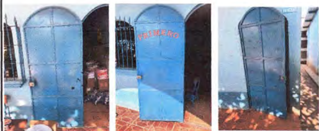
4.1 MANTENIMIENTO A ESTRUCTURA (lijado, fondo base, cepillado, sujeciones, aplicación de pintura)
