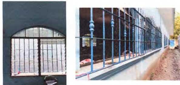
5.2 SUSTITUCION DE ESTRUCTURA DE METAL DE VENTANA (cambio de persianas por ventanas de pvc corredizas)
