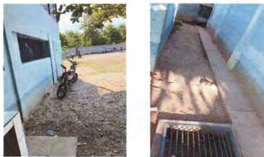
8.2 REPARACION DE BANQUETAS DE CONCRETO (Instalacion de banqueta nueva)
