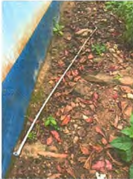
Foto 7. Estado actual red de suministro de agua al establecimiento
