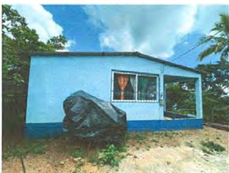
Foto 3. Es necesaria la instalacion de canales de aguas pluviales a ambos lados y así evitar el encharcamiento y erosion por corrimiento de agua.
