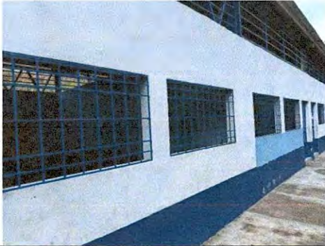
Foto1: Exterior de aulas en donde se propone pintura
