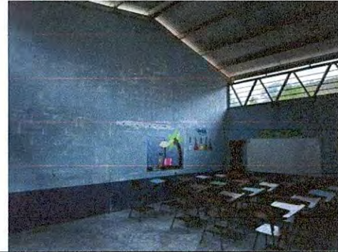
Foto 2: Interior de aulas en donde se propone pintura
