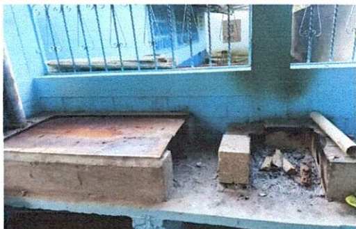
Foto 1: Reparación de polletón en el modulo de cocina (Incluye polletón, chimenea y plancha metálica)
