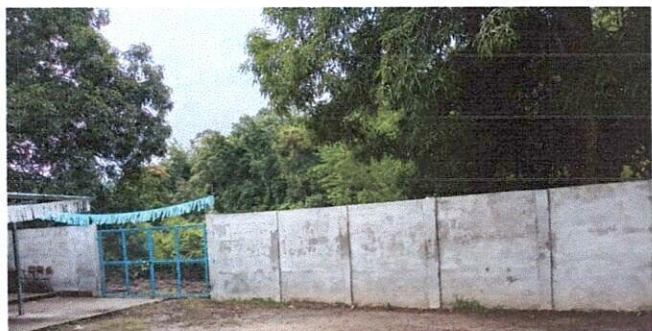
Foto 13: Repello, cernido y pintura en muro perimetral
