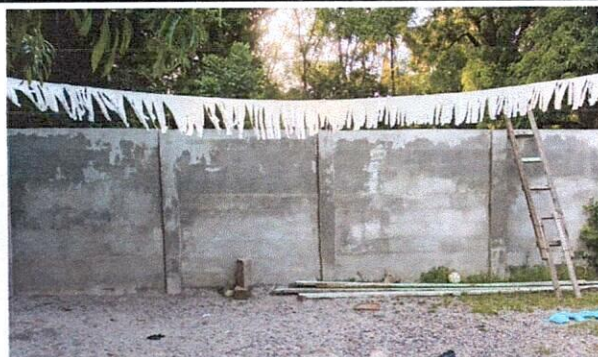
Foto 17: Repello, cernido y pintura en muro perimetral
