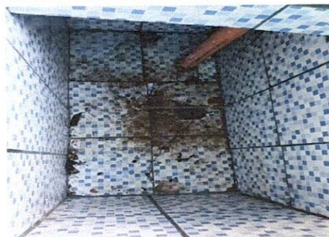
Foto 12: Reparación de pila y sustitución de azulejo dañado
