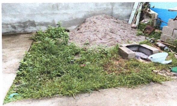
Foto 16: Sustitución de piso de torta de concreto por piso cerámico
