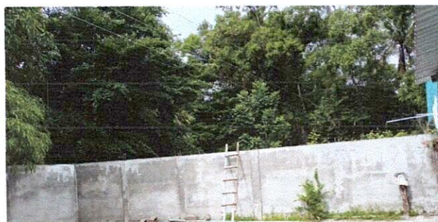
Foto 22: Repello, cernido y pintura en muro perimetral
