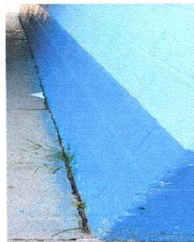
Foto 20: Pintura en muros interiores y exteriores en aulas
