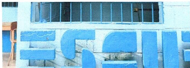
Foto 21: Pintura en muros interiores y exteriores en aulas
