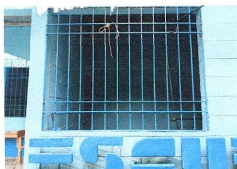
Foto 4: Suministro e instalación de ventanas de PVC corredizas y mantenimiento a balcones
