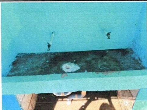
Foto 9: Suministro e instalación de azulejo en lavamanos
