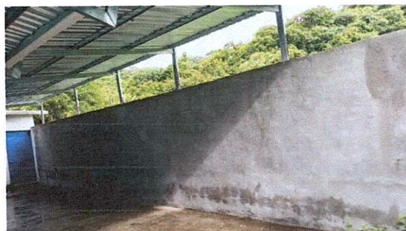
Foto 14: Repello, cernido y pintura en muro perimetral
