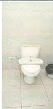
Foto 7: Sustrucción de inodoros y red de tubería principal en baños.
