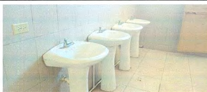
Foto 8: Sustrucción de accesorios en lavamanos y baños.
