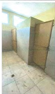
Foto 9: Mantenimiento de puertas, lijado y pintura.
