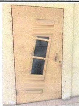
Foto 4: Mantenimiento de puertas en aulas.
