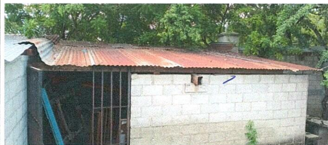
Foto 2: Sustitución de lámina y estructura, canal de metal, muros de block (subir tres hiladas de Block en cocina).
