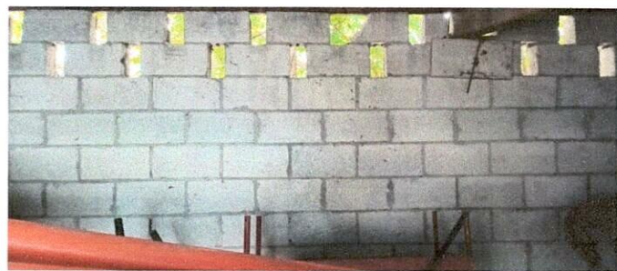
Foto 6: Sustitución de estufa rural completa en cocina.
