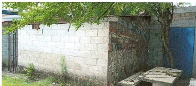
Foto 4: Suministro e instalación de repellos, cernidos, balcones y ventanas PVC en cocina.
