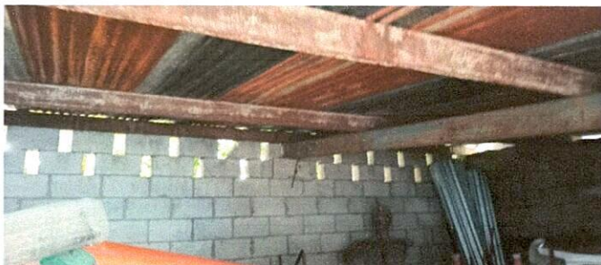
Foto 1: Sustitución de lamina y estructura de soporte en cocina.
