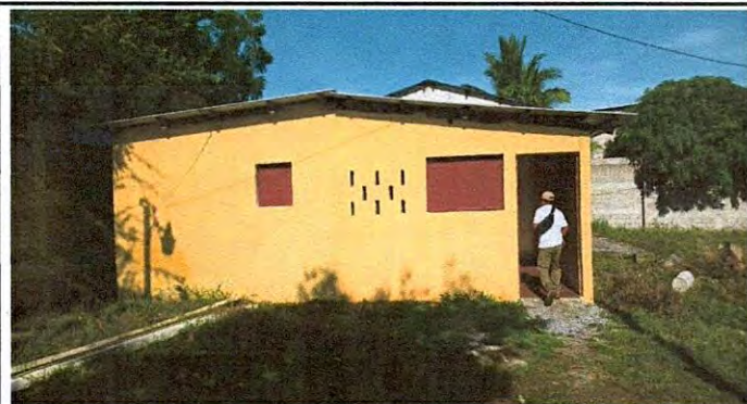
Foto 1: Retiro e Instalación Completa de Lámina y Estructura de Soporte de Metal (Mano de Obra Especializada, los Materiales están en muy Buenas Condiciones) en Cocina
