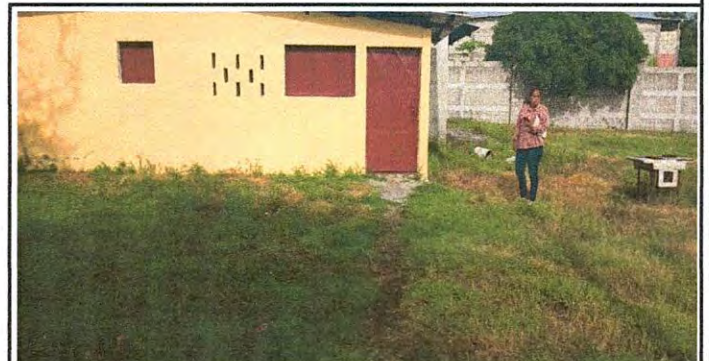
Foto 12: Instalación de Banqueta en Cocina
