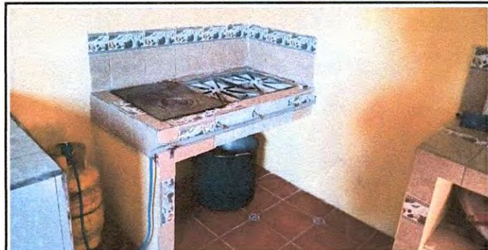
Foto 6: Sustitución de Estufa de Gas por Estufa Rural Completa
