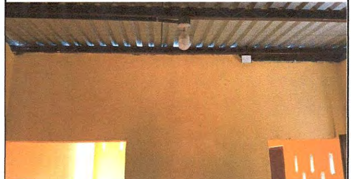
Foto 8: Sustitución de Sistema Eléctrico en Cocina
