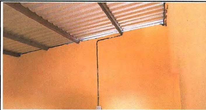
Foto 9: Sustitución de Sistema Eléctrico en Cocina
