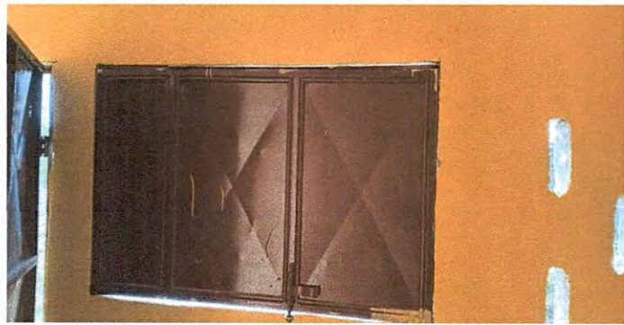
Foto 7: Sustitución de Ventana de Metal por Ventanas PVC y Balcones de Metal en Cocina
