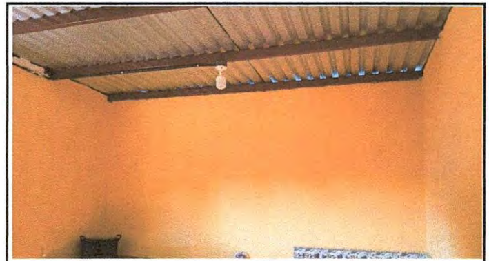
Foto 10: Sustitución de Sistema Eléctrico en Cocina
