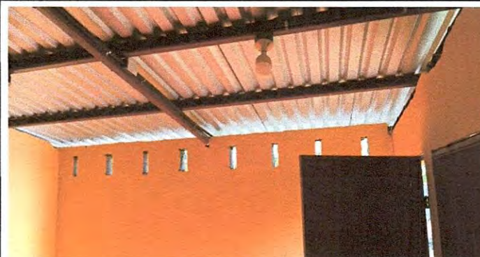
Foto 3: Levantado de Muros, Repellos y Cernidos (Se subirán 3 Hiladas de Block) en Cocina
