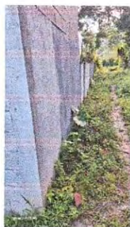
Foto 1: 1.1 Reparación de aguas fluviales, a través de elaboración cuneta tipo L, emparejamiento de terreno y compactación.
