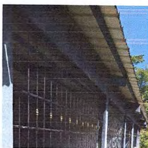
Foto 11: Reparación de balcón
