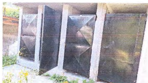
Foto 2: 2.1 Reparación de puertas de metal y columnas principales
