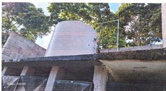
Foto 3: 2.3 Reparación de terraza, salidas y caídas de aguas pluviales
