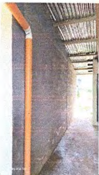
Foto 7: 4.3 Repello exterior de muros
