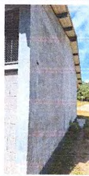
Foto 8: Repello exterior de muros
