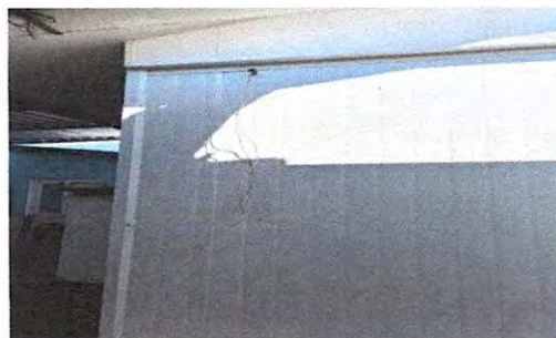
Foto 10: SISTEMA ELECTRICO; SUSTITUCIÓN DE DUCTO MAS ACCESORIOS
