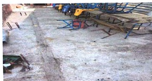
Foto 6: SUSTITUCION DE PISO LIQUIDO
