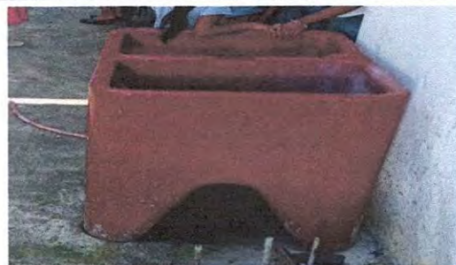
FOTO 8: SUSTITUCIÓN DE PILA PLÁSTICA PORTATIL DE UN LAVAMANOS POR PILA DE BLOCK, MEDIDA 2X1X1 MTS
