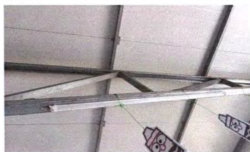
Foto 9: SISTEMA ELECTRICO; SUSTITUCIÓN DE LÁMPARAS
