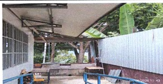
Foto2: SUSTITUCIÓN DE ESTRUCTURA DE METAL POR METAL, Y MADERA POR METAL
