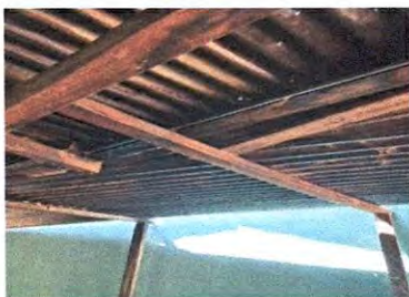
Foto1: SUSTITUCIÓN DE ESTRUCTURA DE METAL POR METAL, Y MADERA POR METAL
