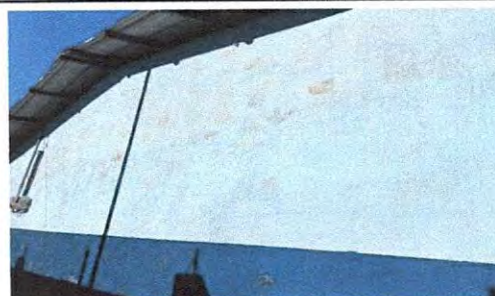
Foto 4: PINTURA EN MUROS EXTERIORES
