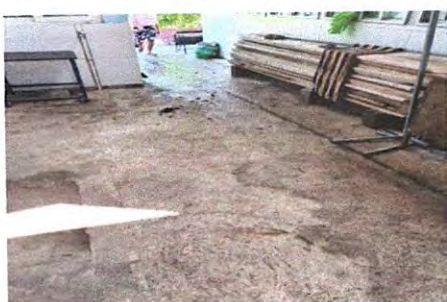
Foto 5: SUSTITUCIÓN DE PISO DE TORTA A PISO CERAMICO
