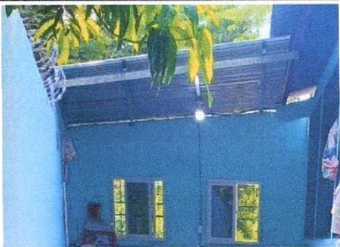
SUSTITUCIÓN DE DUCTO ELECTRICO + ACCESORIOS
