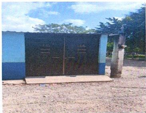
SUSTITUCIÓN DE PORTÓN DE METAL
