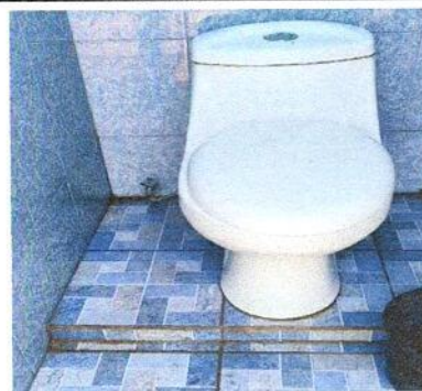
REPARACIÓN DE TUBERIA DE SANITARIOS
