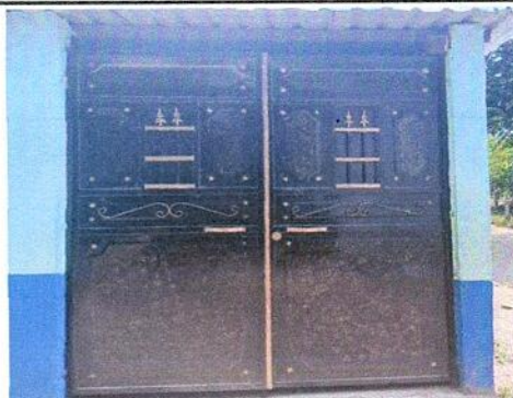
MANTENIMIENTO DE PUERTA (REEMPLAZO DE ANGULAR PARA SUJECCIÓN DE PUERTA+ TRATAMIENTO ANTICORROSIVO CON PINTURA)
