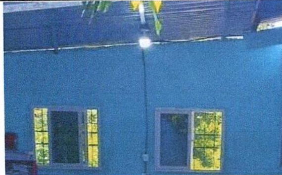
SUSTITUCIÓN DE INTERRUPTOR
