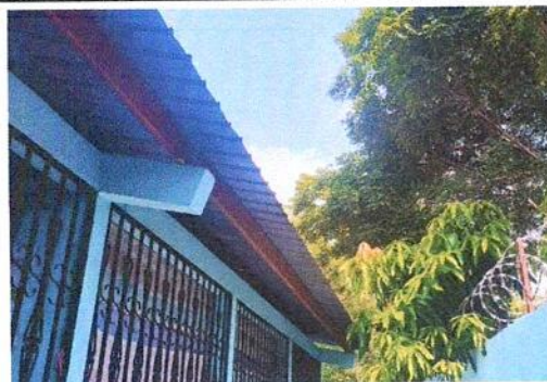
INSTALACIÓN DE CANAL METÁLICO DE AGUA PLUVIAL
