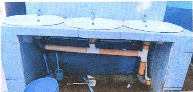
REPARACIÓN DE TUBERIA DE LAVAMANOS
