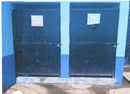
MANTENIMIENTO A ESTRUCTURA ( LIJADO, CEPILLADO, PINTURA PUERTAS DE SERVICIOS SANITARIOS)
