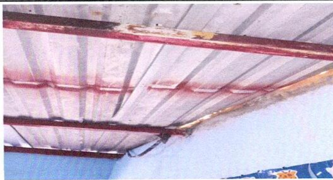
SUSTITUCIÓN DE ELEMENTOS DE FIJACIÓN
