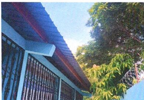
INSTALACIÓN DE PESCANTE DE METAL PARA CANAL
