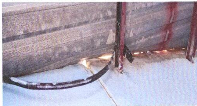
REPARACIÓN DE CABLEADO ELECTRICO
