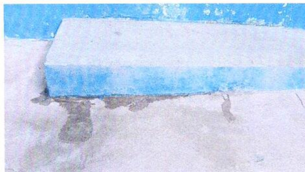
SUSTITUCIÓN DE CAJA DE REGISTRO
