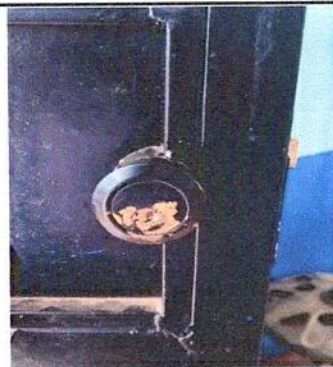
SUSTITUCIÓN DE CHAPA
