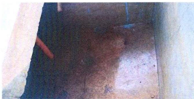
SUSTITUCIÓN DE DRENAJE DE PILA
