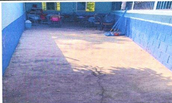
SUSTITUCIÓN DE PISO CERÁMICO
