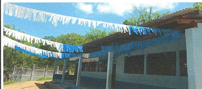
Foto 2: Instalación de canal de metal para aguas e lluvia (incluye: bajadas de agua).
