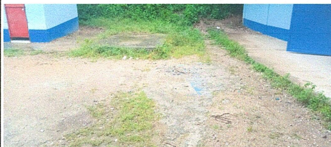
Foto 10: Sustitución de planchas de concreto en patio.
