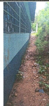
Foto 6: sustitución de banquetas de concreto, en aulas (banquetas soterradas en mal estado).
