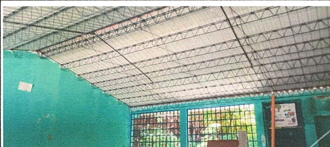
Foto 3: Instalaciones eléctricas en aulas.
