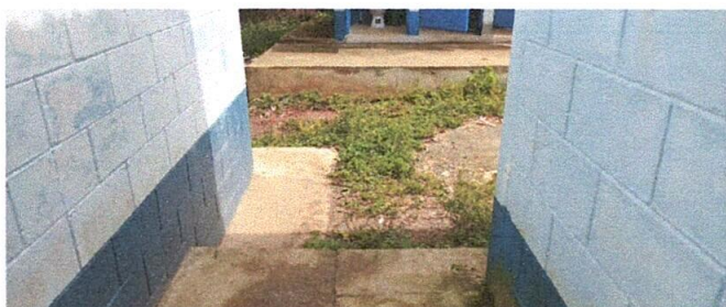
Foto 9: Sustitución de planchas de concreto en patio.
