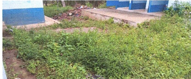
Foto 10: Sustitución de planchas de concreto en patio.
