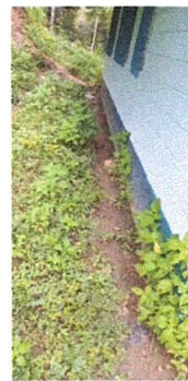
Foto 4: Repellos, cernidos e impermeabilización en aulas.
