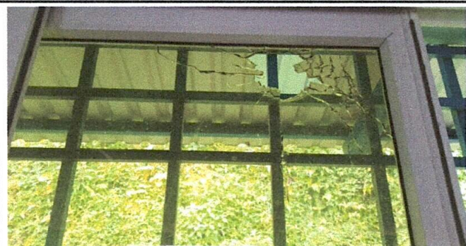
Foto 5: Sustitución de vidrio en ventanas PVC en aulas.
