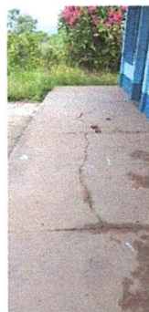
Foto 6: Sustitución de piso de concreto y suministro de piso cerámico mate en corredor de aulas.
