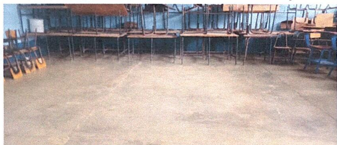
Foto 1: Instalación de piso cerámico mate en aulas.
