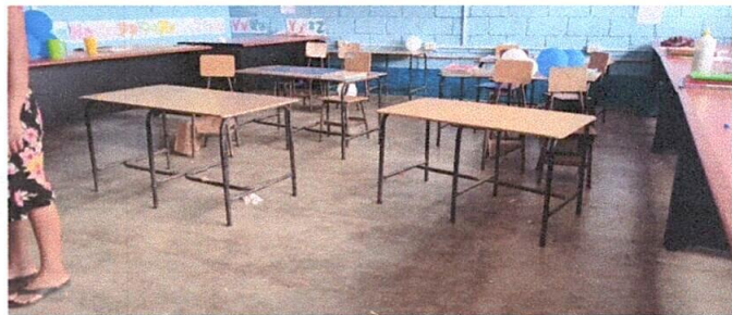
Foto 2: Instalación de piso cerámico mate en aulas.
