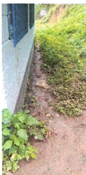
Foto 3: Sustitución de banquetas y suministro de pileta de concreto.
