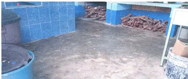
Foto 7: Suministro e instalación de piso cerámico mate en cocina.
