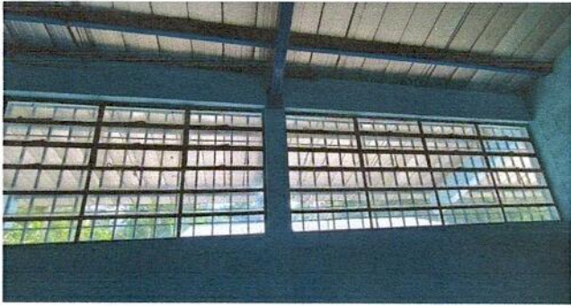
SUSTITUCIÓN DE VENTANAS POR VENTANAS PVC CORREDIZA BLANCA
