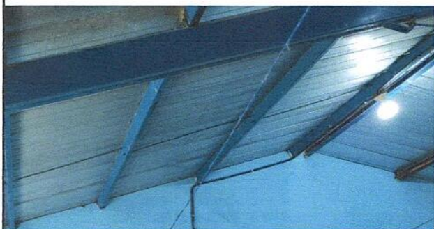
SUSTITUCIÓN DE FOCOS AHORRADORES
