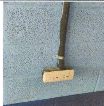
SUSTITUCIÓN DE TOMACORRIENTES DOBLES
