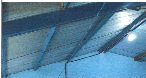
SUSTITUCIÓN DE PLAFONERA
