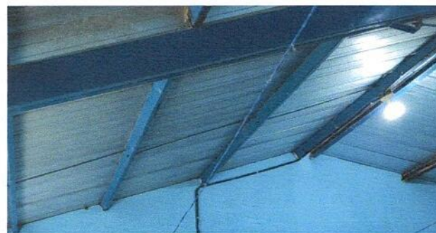
REPARACIÓN DE CABLEADO ELECTRICO
