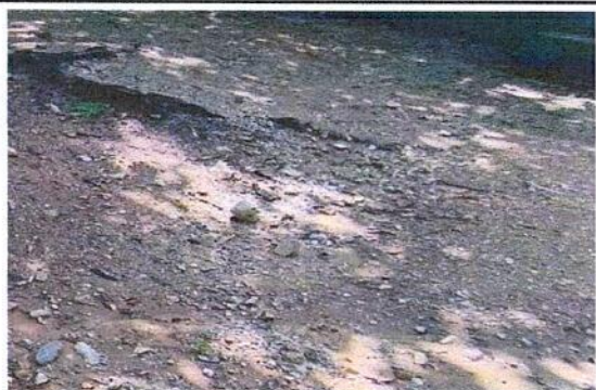
APLICACIÓN DE TORTA DE CONCRETO EN ÁREA DE PATIO , BASE IRREGULAR DE TIERRA, INCLUYE LIMPIEZA, NIVELACIÓN, COMPACTADO Y COLADO DE CONCRETO SIMPLE
