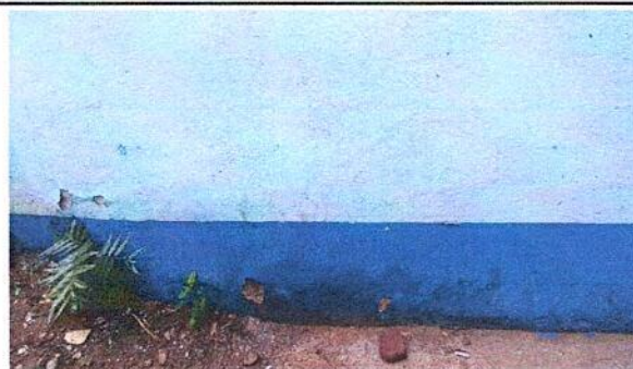
APLICACIÓN DE REPELLO Y CERNIDO EN PAREDES, INCLUYE LIMPIEZA, APLICACIÓN DE REPELLO GRUESO Y CERNIDO FINO
