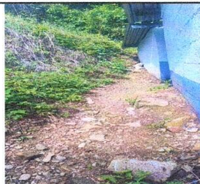
REPARACIÓN DE BANQUETA EN ÁREA DE COCINA PARTE TRASERA, INCLUYE EXCAVACIÓN, COMPACTADO, BASE Y COLADO DE CONCRETO
