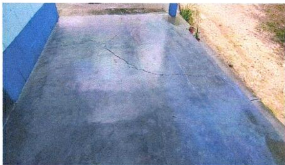
INSTALACIÓN DE PISO CERÁMICO EN SALÓN, CORREDOR , DIRECCIÓN Y BODEGA, INCLUYE NIVELACIÓN, COLOCACIÓN, BOQUILLA Y LIMPIEZA FINAL
