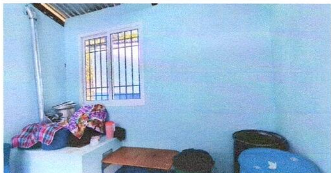
INSTALACIÓN DE REPISAS DE CONCRETO 2.00 X2.00M Y 0.50 M DE FONDO. INCLUYE ESTRUCTURA DE CONCRETO + ACABADO CON AZULEJO
