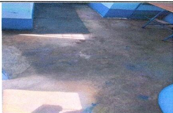
INSTALACIÓN DE PISO CERÁMICO EN COCINA SOBRE BASE DE CONCRETO EXISTENTE, INCLUYE COLOCACIÓN, NIVELACIÓN MENOR, APLICACIÓN DE ADHESIVO Y BOQUILLA
