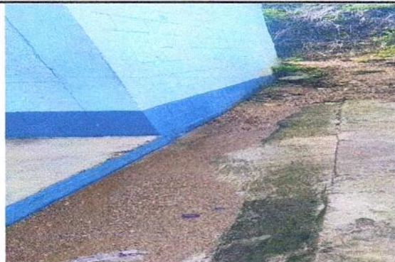
REPARACIÓN DE CUNETA DE CONCRETO, VOLUMEN ESTIMADO 0.40M2 INCLUYE DEMOLICIÓN PARCIAL, LIMPIEZA, ENCOFRADO Y COLADO DE CONCRETO SIMPLE
