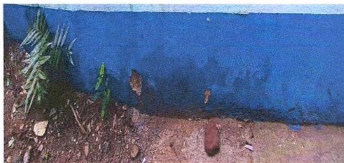
APLICACIÓN DE TRATAMIENTO ANTIHUMEDAD, INCLUYE LIMPIEZA Y APLICACIÓN DE IMPERMEABILIZANTE
