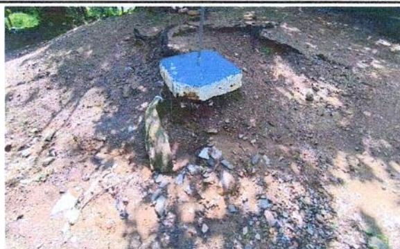
APLICACIÓN DE TORTA DE CONCRETO EN ÁREA DE PATIO, BASE IRREGULAR DE TIERRA, INCLUYE LIMPIEZA, NIVELACIÓN, COMPACTADO Y COLADO DE CONCRETO SIMPLE
