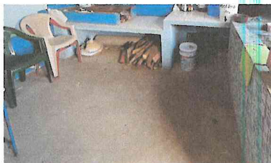
Foto 10: Sustitución de piso de torta de concreto por piso cerámico
