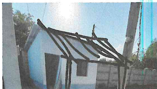
Foto 16: Sustitución de columnas de galera, de estructura de soporte de madera por metal y de lámina troquelada calibre 26
