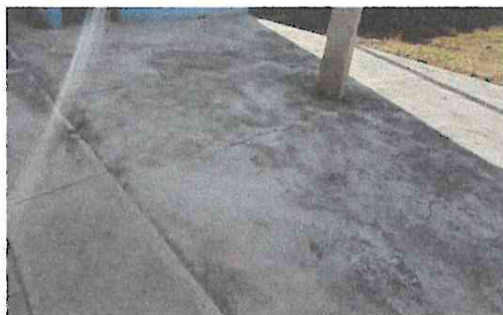
Foto 9: Sustitución de piso de torta de concreto dañada por piso de igual consistencia
