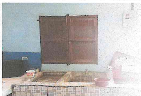
Foto 11: Mantenimiento a estructura de metal de ventana del area de cocina (Lijado, cepillado y aplicación de pintura)
