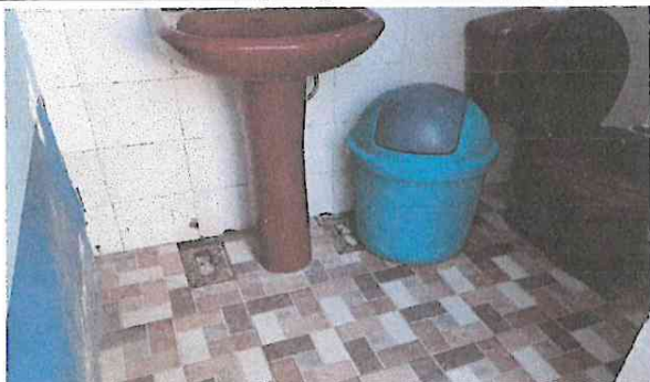
Foto 19: Sustrucción de piso cerámico y azulejo dañado en el modulo de baños
