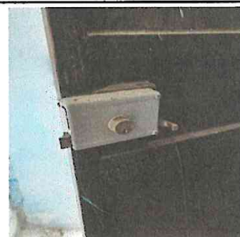
Foto 18: Sustitución de chapa derecha de puerta metálica
