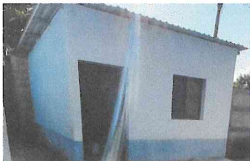
Foto7: Pintura en muros interiores y exteriores
