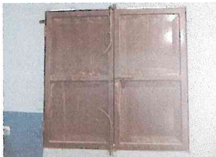
Foto 13: Mantenimiento a estructura de metal de ventana del area de cocina (Lijado, cepillado y aplicación de pintura)
