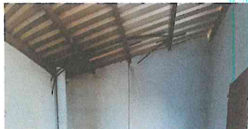
Foto 8: Sustitución de estructura de soporte de metal dañada por estructura nueva y sustitución de lámina troquelada.....
