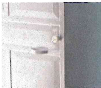
Foto 15: Sustitución de chapa derecha de puerta metálica
