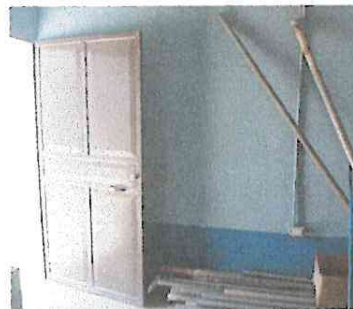
Foto 14: Mantenimiento a estructura de puerta (Lijado, Cepillado, cambio de tubo, sujeciones y cambio de pintura)
