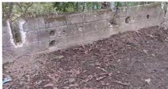
3.3 Reparación de muro de contención y reforzamiento; (Sellado de grietas y fisuras colocando una biga para reforzamiento y aplicando repello); 1x15ML
