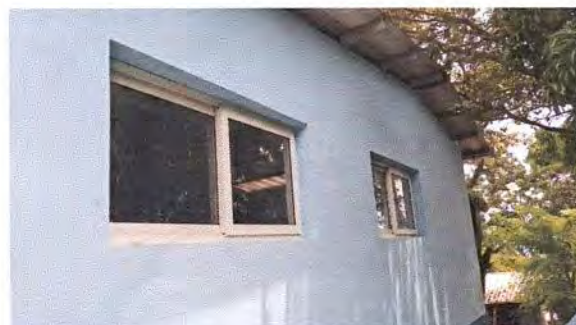
1.1 Elaboración e instalación de balcones de 2 x 1 x 9 18 m2
