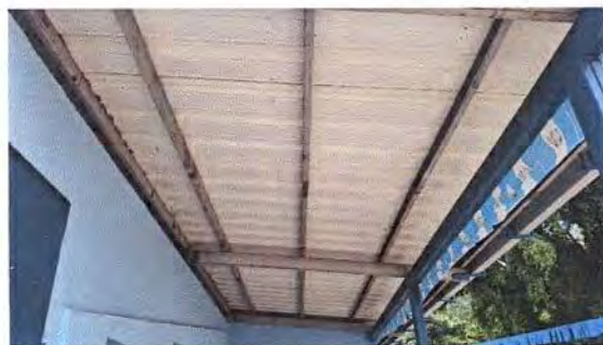
4.2 Instalación de plafoneras
