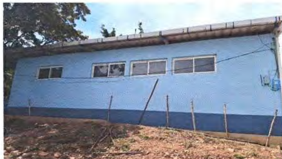
1.1 Elaboración e instalación de balcones de 2 x 1 x 9 18 m2
