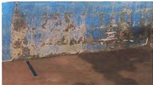
2.1 Reparación de pared, corredor de bodega, por filtración de agua (sellado de grietas y repello) de 10 ml
