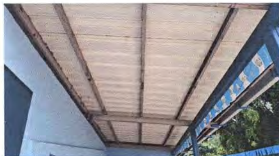
4.7 Instalación de cajas rectangulares.
