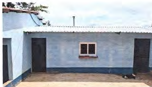
3.2 Pintura de aula de 200 M2
