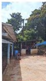
1.3 Instalación de tubería de drenaje de línea principal de agua pluvial 60ml
