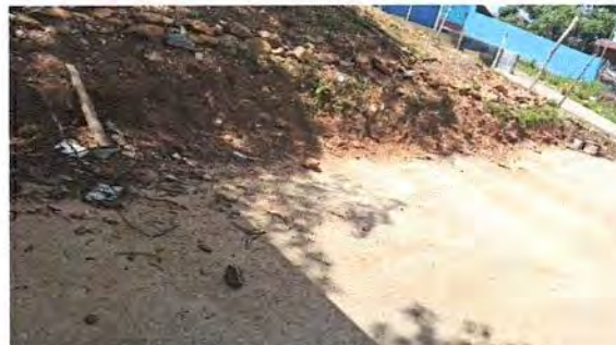
3.1 Instalación de tubería de drenaje de línea principal de agua pluvial 60ml
