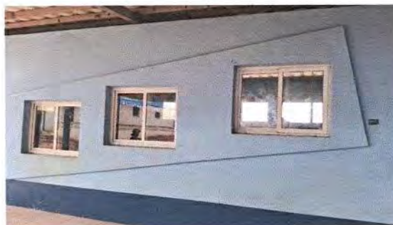
1.2 Elaboración e instalación de balcones de 1x1.5. 10.50 m2
