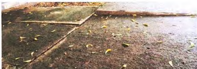
3.5 Sustitución de torta de concreto por deterioro a torta de concreto de patio 18.75 m2
