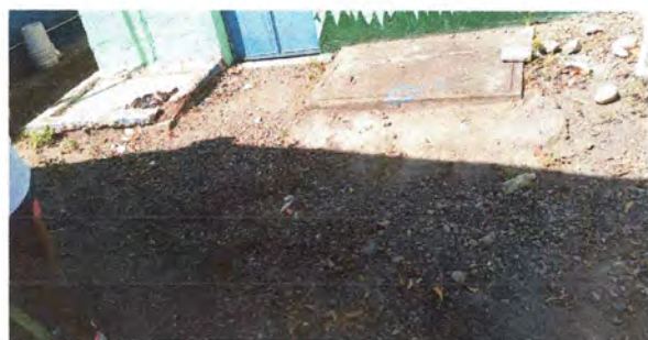
Foto 5: Sustitución de piso de torta de concreto frente al área de cocina
