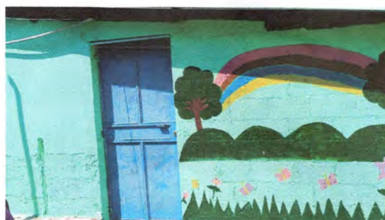
Foto 14: Mantenimiento a estructura (Lijado, Cambio de tubo, cepillado, sujeciones y aplicación de pintura)
