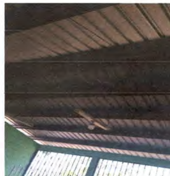
Foto 26: Sustrucción de caja de lampara de tubo por plafonera
