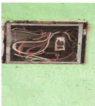
Foto 23: Sustitución de tablero de flipones
