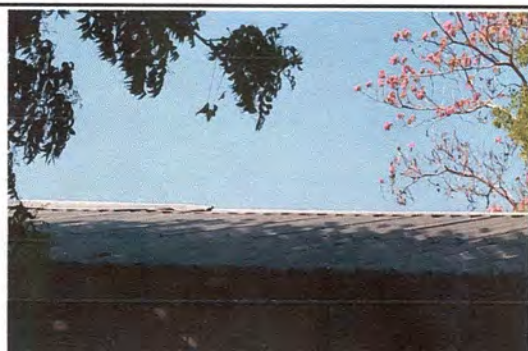
Foto 11: Sustrución de lámina por lámina troquelada aluzinc calibre 26 en el modulo de aulas
