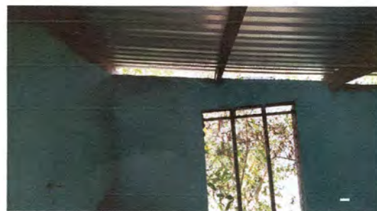
Foto 8: Sustrución de estructura de soporte de metal por metal
