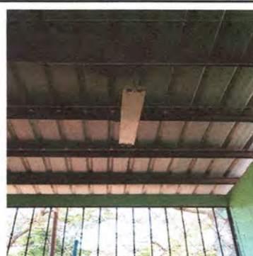
Foto 22: Sustitución de caja de lampara de tubo por plafonera
