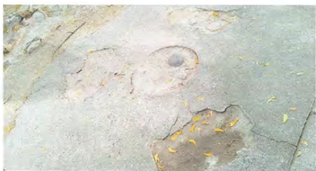
Foto 27: Sustrucción de piso de torta de concreto entrada principal
