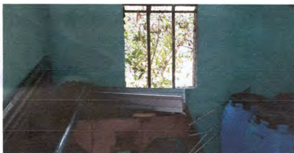
Foto 15: Sustitución de ventana de madera por metal más vidrio
