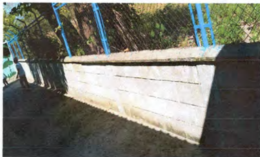
Foto1: Repello y cernido en muros
