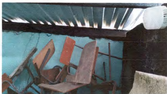
Foto 9: Sustrución de lámina por lámina troquelada aluzinc calibre 26
