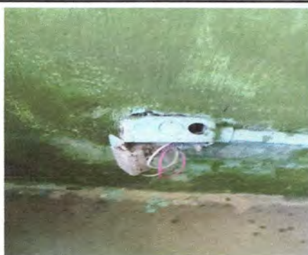
Foto 20: Sustitución de tomacorrientes dobles
