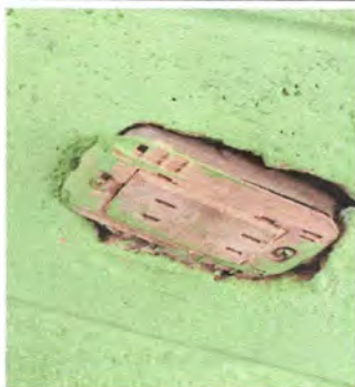
Foto 25: Sustrucción de tomacorrientes dobles
