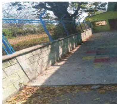
Foto 2: Repello y cernido en muros
