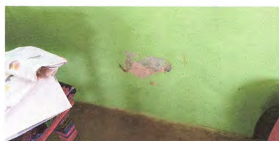
Foto 18: Pintura en muros exteriores e interiores
