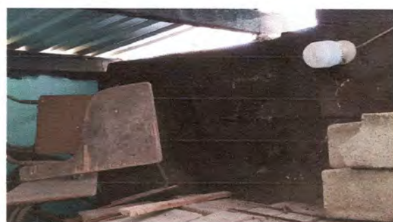
Foto 10: Sustrución de lámina por lámina troquelada aluzinc calibre 26
