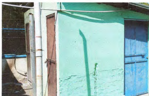
Foto 13: Mantenimiento a estructura (Lijado, Cambio de tubo, cepillado, sujeciones y aplicación de pintura)
