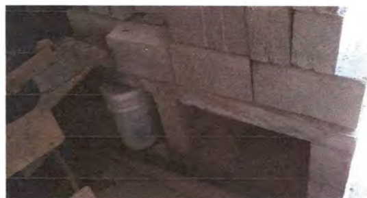
Foto 16: Sustitución de estufa rural completa (Incluye polletón, plancha y chimenea)
