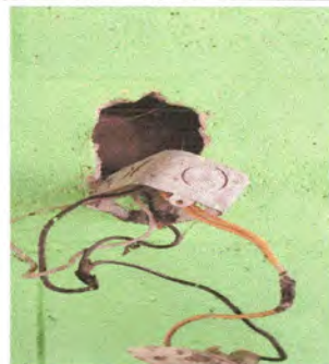
Foto 24: Sustitución de tomacorrientes dobles
