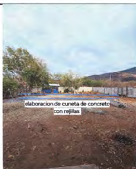
Foto 5: construcción de cuneta de concreto con rejilla, lo marcado es el lugar donde se instalaría dicha cuneta, ya que es el lugar por donde pasa una quebrada en época de invierno y esto hace que se mantenga mucha
