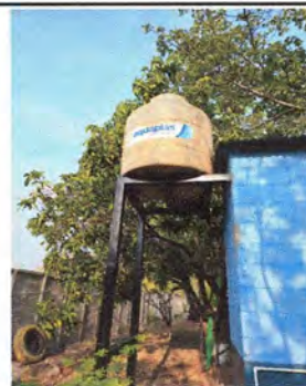
Foto 4: sustitución de tinaco elevado de agua de 2000 litros
