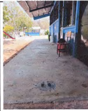
Demolición y elaboración de torta de concreto compactada
