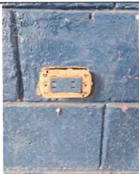
Foto1: Sustitución de interruptores simples y cableado eléctrico
