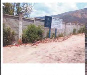
Foto 6: Pintura en muro perimetral de la parte exterior de la escuela
