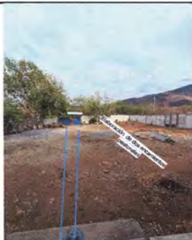
Foto 3: construcción de dos encaminamientos de concreto de la entrada principal, dicha escuela no cuenta con una entrada encementada y se mantiene agua encharcada que pasa una quebrada y los niños y niñas se
