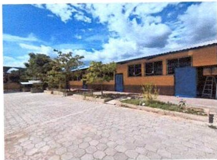
Foto 5: Elaboracion de 42 Ventanas de Pvc de 1.65mt d ancho por 1.40 mt de alto cubicando 2.31 M2 cada una para un total de 97.02 mts2
