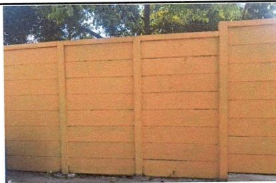
Foto 4: Pintura interior en muro perimetral cubriendo 340mts cuadrados
