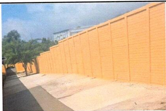
Foto 3: Pintura interior en muro perimetral cubriendo 340mts cuadrados
