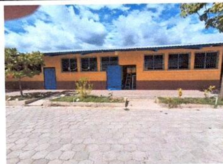
Foto 6: Elaboracion de 42 Ventanas de Pvc de 1.65mt d ancho por 1.40 mt de alto cubicando 2.31 M2 cada una para un total de 97.02 mts2
