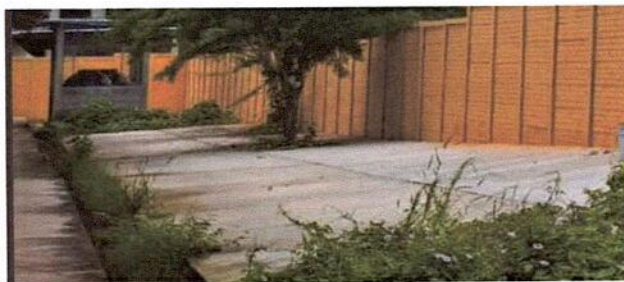
Foto 2: Colocación de planchas de concreto de patio de 83mts cuadrados
