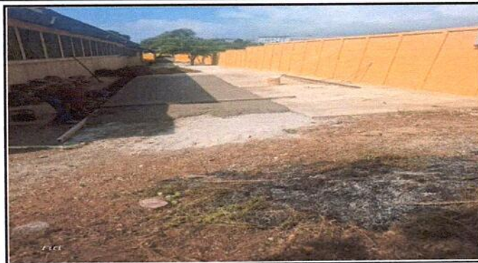
Foto 2: Colocación de planchas de concreto de patio de 83mts cuadrados
