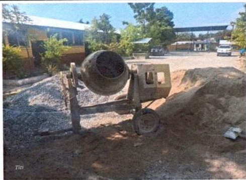
Foto1: Colocación de planchas de concreto de patio de 83mts cuadrados
