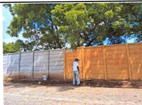
Foto 4: Pintura interior en muro perimetral cubriendo 340mts cuadrados
