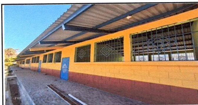
Foto 5: Elaboracion de 42 Ventanas de Pvc de 1.65mt d ancho por 1.40 mt de alto cubicando 2.31 M2 cada una para un total de 97.02 mts2
