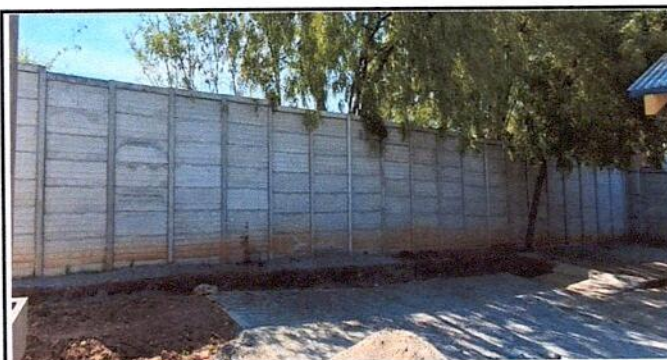
Foto 4: Pintura interior en muro perimetral cubriendo 340mts cuadrados
