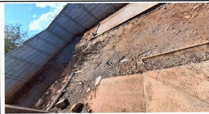
Foto1: Colocación de planchas de patio de 83mts cuadrados
