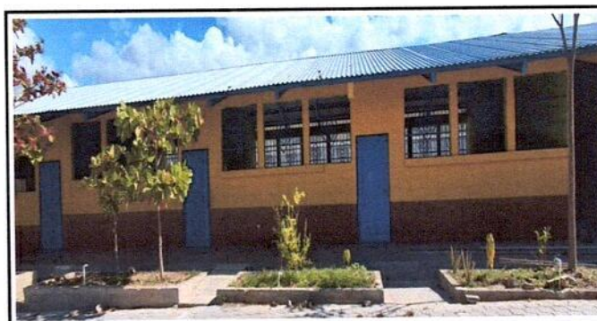
Foto 6: Elaboracion de 42 Ventanas de Pvc de 1.65mt d ancho por 1.40 mt de alto cubicando 2.31 M2 cada una para un total de 97.02 mts2
