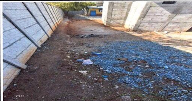
Foto 2: Colocación de planchas de patio de 83mts cuadrados
