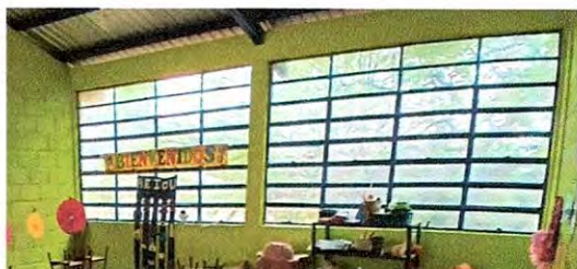
Foto 11: sustitución de ventanas de metal con vidrio por ventana de pvc con vidrio en aula 1
