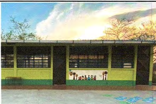
Foto 17: sustitución de ventanas de metal con vidrio por ventana de pvc con vidrio en aula 1 y 2 de la parte de enfrente
