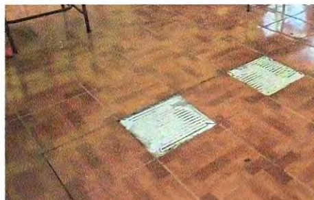
Foto 20: Demolición de piso cerámico existente, es resbaladizo con textura liso brillante y se esta despegando, sustitución de piso cerámico resbaladizo por piso cerámico mate antideslizante en el aula 2
