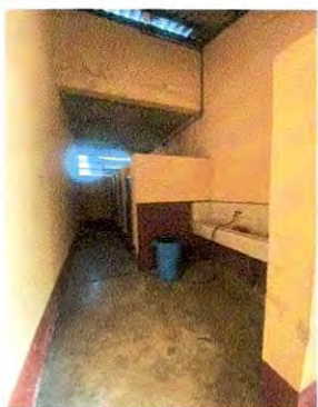
Foto 9: Reparación de piso de torta de concreto, Sustitución de piso de torta de concreto por piso cerámico con zócalo, Pintura en muro interior en los servicios sanitarios
