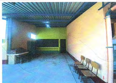
Foto 18: Pintura en muro exterior de servicio sanitario
