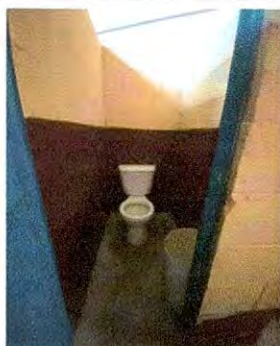
Foto 5: Sustitución de inodoro 3 en los servicios sanitarios
