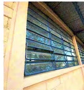
Foto 12: sustitución de ventanas de metal con vidrio por ventana de pvc con vidrio en aula 2
