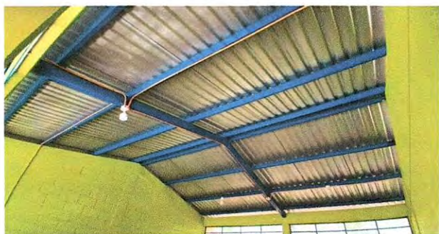
Foto 13: Instalación de cielo falso vinílico, Instalación de ventiladores de techo en aula 1
