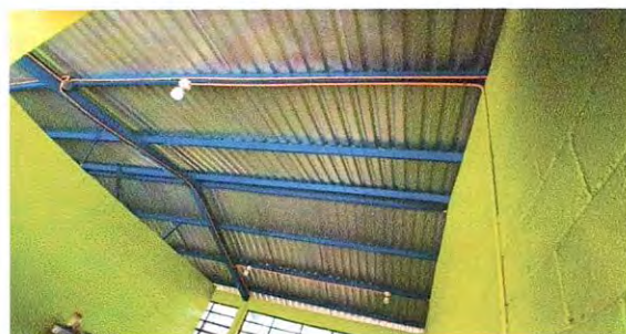
Foto 14: Instalación de cielo falso vinílico, Instalación de ventiladores de techo en aula 2
