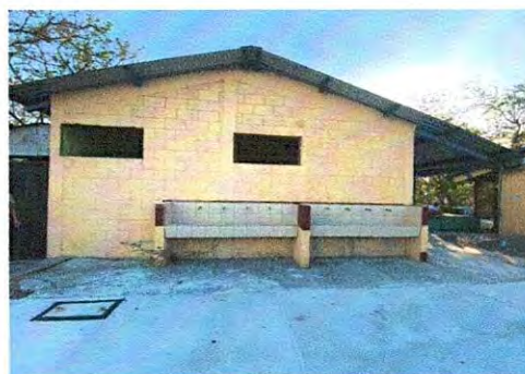
Foto 16: Fabricación e instalación de alero de estructura de metal y lamina en lavamanos que estan en el corredor
