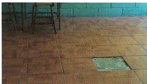
Foto 19: Demolición de piso cerámico existente, es resbaladizo con textura liso brillante y se esta despegando, sustitución de piso cerámico resbaladizo por piso cerámico mate antideslizante en el aula 1
