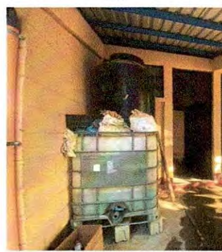
Foto 10: Pintura en muro exterior de los servicios sanitarios
