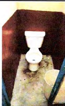
Foto 3: Sustitución de inodoro 2 en los servicios sanitarios
