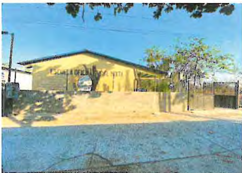
Foto1: Reparación de muro aplicando repello y cernido, Pintura en ambos lados del muro y trazo del nombre con logotipo de la escuela en fachada del muro perimetral
