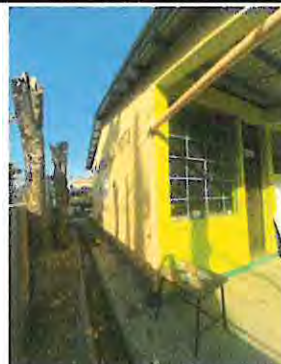
Foto 14: Reparación de bajada de agua pluvial en corredor
