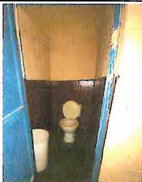
Foto 9: Sustitución de inodoro 2 en los servicios sanitarios
