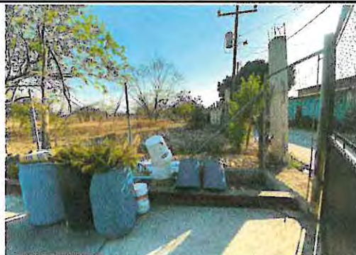
Foto 2: Reparación de tubo Hg y malla galvanizada en muro perimetral
