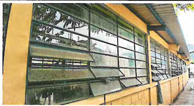
Foto 6: sustitución de ventanas de metal con vidrio por ventana de pvc con vidrio en aulas 1, 2 y 3
