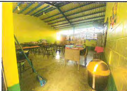
Foto 4: Reparación de piso de concreto para nivelar, Sustitución de piso de torta de concreto por piso cerámico con zócalo, Instalación de ventiladores de techo en aula 2
