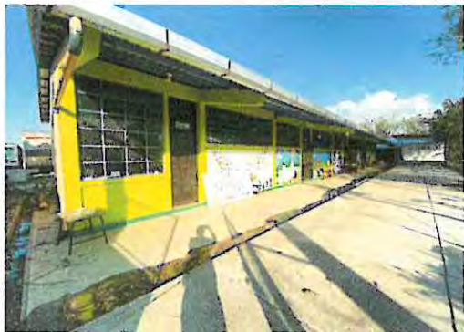
Foto 7: Pintura en muro exterior en aulas 1,2 y 3
