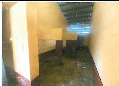
Foto 12: Sustitución de piso de torta de concreto por piso cerámico con zócalo y Pintura en muro interior en los servicios sanitarios
