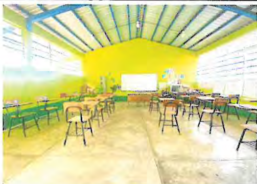
Foto 3: Reparación de piso de concreto para nivelar, Sustitución de piso de torta de concreto por piso cerámico con zócalo, Instalación de ventiladores de techo en aula 1
