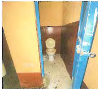
Foto 8: Sustitución de inodoro 1 en los servicios sanitarios
