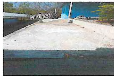
FOTO 2: sustitución de planchas de concreto en patio.
