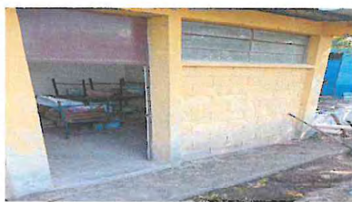
FOTO 4: Demolición de muro existente, Instalación de ventana PVC, Instalación de balcones de metal en cocina.
