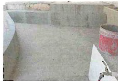
FOTO 4: Instalación de piso cerámico en baños.
