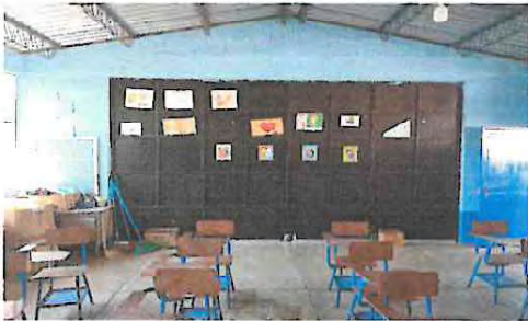
FOTO 1: Mantenimiento de división de metal en aulas.
