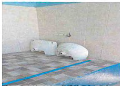
FOTO 3: sustitución de lavamanos con base de block en baños.
