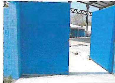
FOTO 4: mantenimiento en porton entrada principal.
