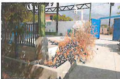
FOTO 5: Instalación de baranda de metal de 5mts de largo por 1 mts de alto en patio
