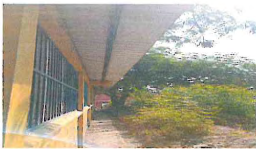
FOTO 3: Instalación de canal de metal en aulas.
