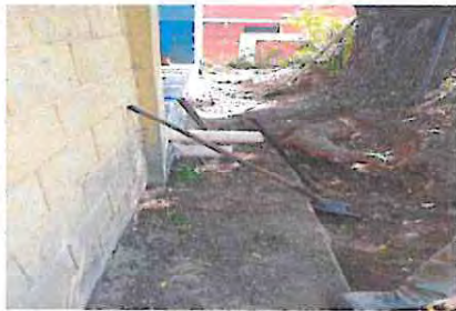
FOTO 1: Instalación de agua potable
