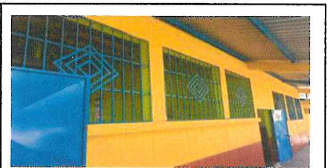
Foto 4: Elaboracion de 42 Ventanas de Pvc de 1.65mt d ancho por 1.40 mt de alto cubicando 2.31 M2 cada una para un total de 97.02 mts2
