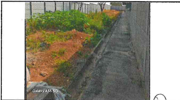
Foto 3: Colocacion de planchas de cemento en patio cubriendo 321 metros cuadrados
