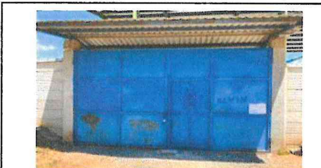
Foto 5: Mantenimiento a porton de metal el cual cubica 1.875 METROS2 incluyendo pintura y elaboracion de monograma
