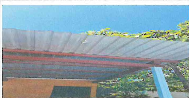
Foto1: Desmontaje de cubierta + estructura de techo existente
