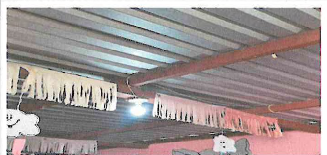
Foto 5: Suministro e instalación de lamapara + plafonera
