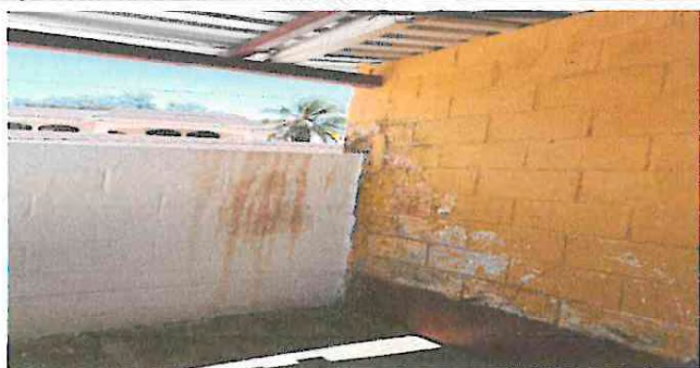
Foto 1: Pintura en muros interiores y exteriores
