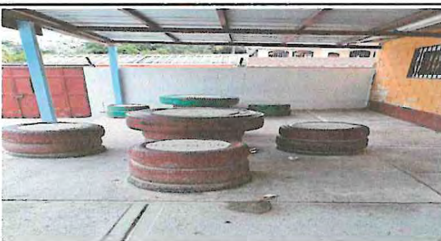
Foto 5: Demolición de mesas de concreto existentes
