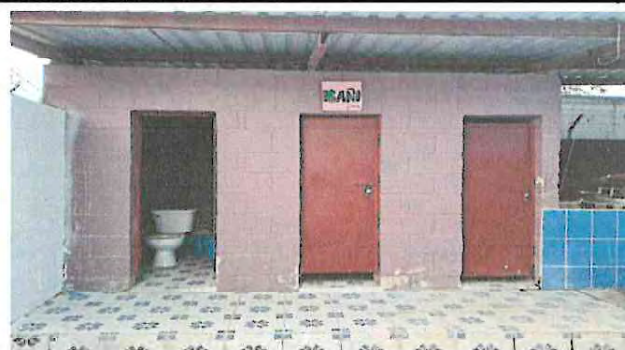
Foto 4: Retiro, suministro e instalación de baños
