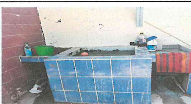
Foto 4: Pila de concreto con un lavadero y forrada de azulejo
