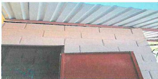
Foto1: Desmontaje de cubierta + estructura de techo existente en bodega
