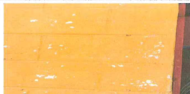
Foto 6: Repello y cernido en paredes
