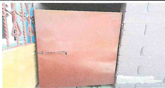
Foto 3: Suministro e instalación de puerta de metal con chapa de sobreponer
