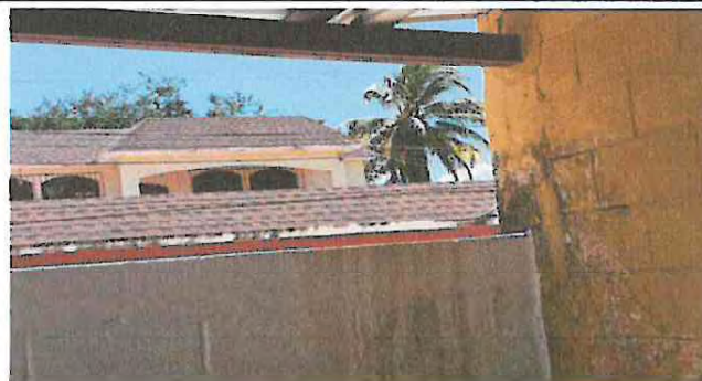
Foto 2: Levantado de muros de block pineado a altura de mojinete
