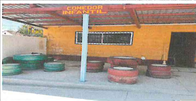
Foto 3: Montaje de estructura de techo + cubierta
