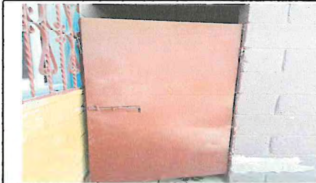
Foto 2: Mantenimiento de puerta de metal en modulo de baños
