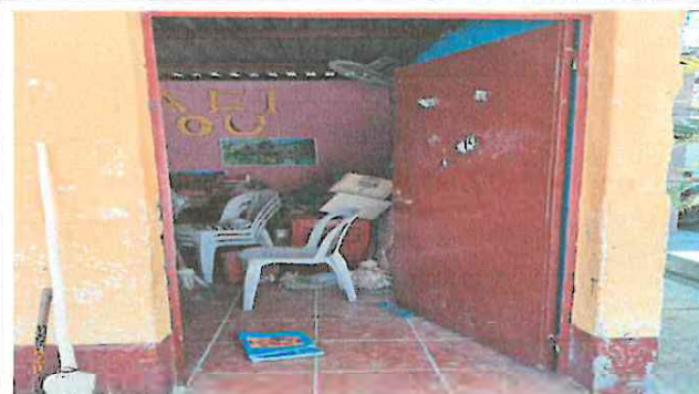
Foto 2: Polleton de concreto + tubo de extractor de humo
